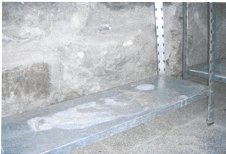
Kamienna ściana w piwnicy
