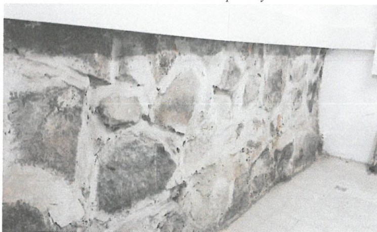
Kamienna ściana w piwnicy
