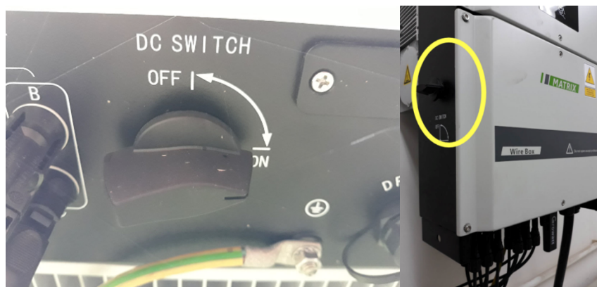
Rys. 14. Przykładowa lokalizacja wyłącznika głównego falownika. Źródło: opracowanie własne.
