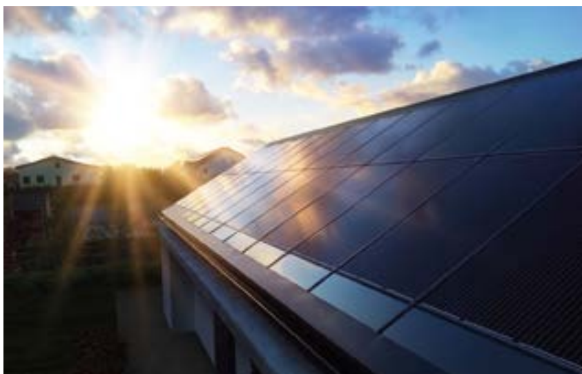
■ Dach solarny 2w1
