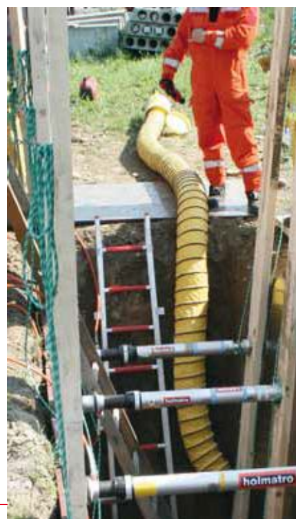
Prowadzenie wentylacji mechanicznej wykopu
