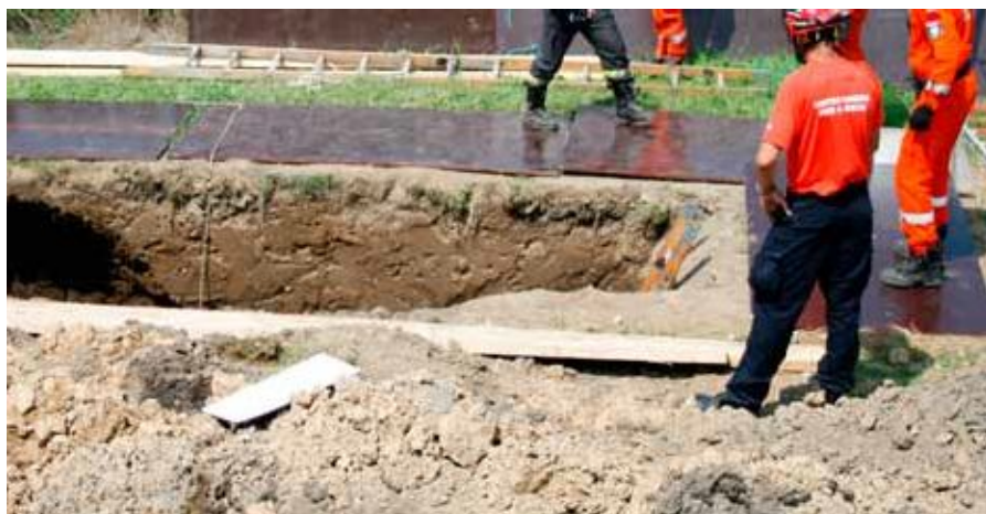
Umocnienie brzegów wykopu
