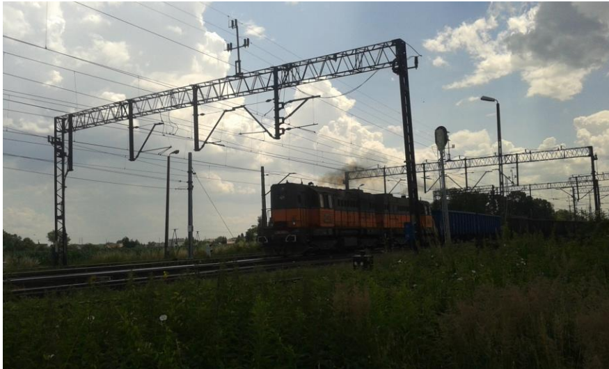
Fot. 2. Chałupki, RB1. Linie kolejowe nr 151 i 158 w kierunku dworca PKP.
