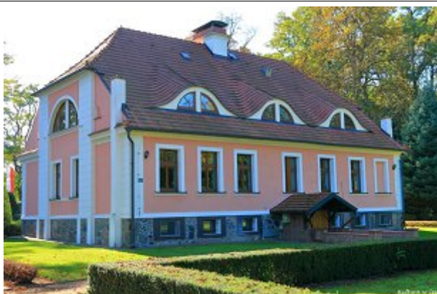
Dwór, elewacja północna
