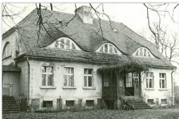
Dwór w 1981 roku, widoczny drewniany ganek zlikwidowany w czasie remontu w 1998 r. (NID)
