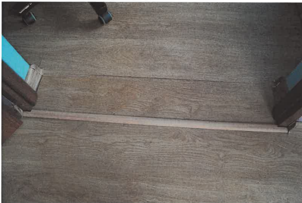
Istniejące panele podłogowe
