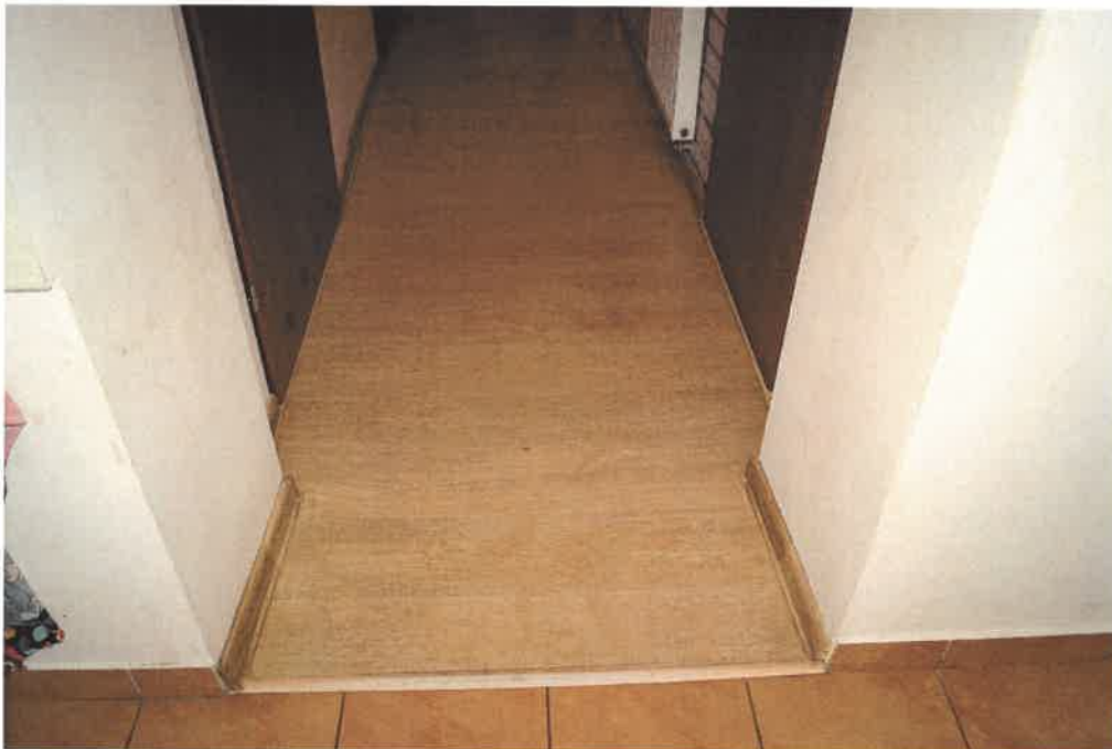
Istniejące panele podłogowe w korytarzu
