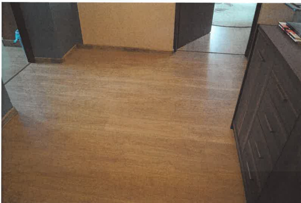
Istniejące panele podłogowe
