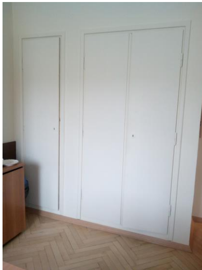
Zdj. Nr 1 Widok Szaf w pokoju biurowym
