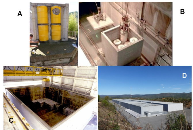
Rys. 3. Zdjęcia składowiska LILW w El Cabril (udostępnione uczestnikom wyjazdu stażowo-szkoleniowego przez TECNATOM S.A.). A – przekrój betonowych kontenerów pokazujący sposób ułożenia beczek z LILW. B – napełnianie kontenerów beczkami z odpadami promieniotwórczymi odbywający się automatycznie. C – napełnianie krypt betonowymi kontenerami. D – widok sekcji krypt przygotowanych do pokrycia glebą.
