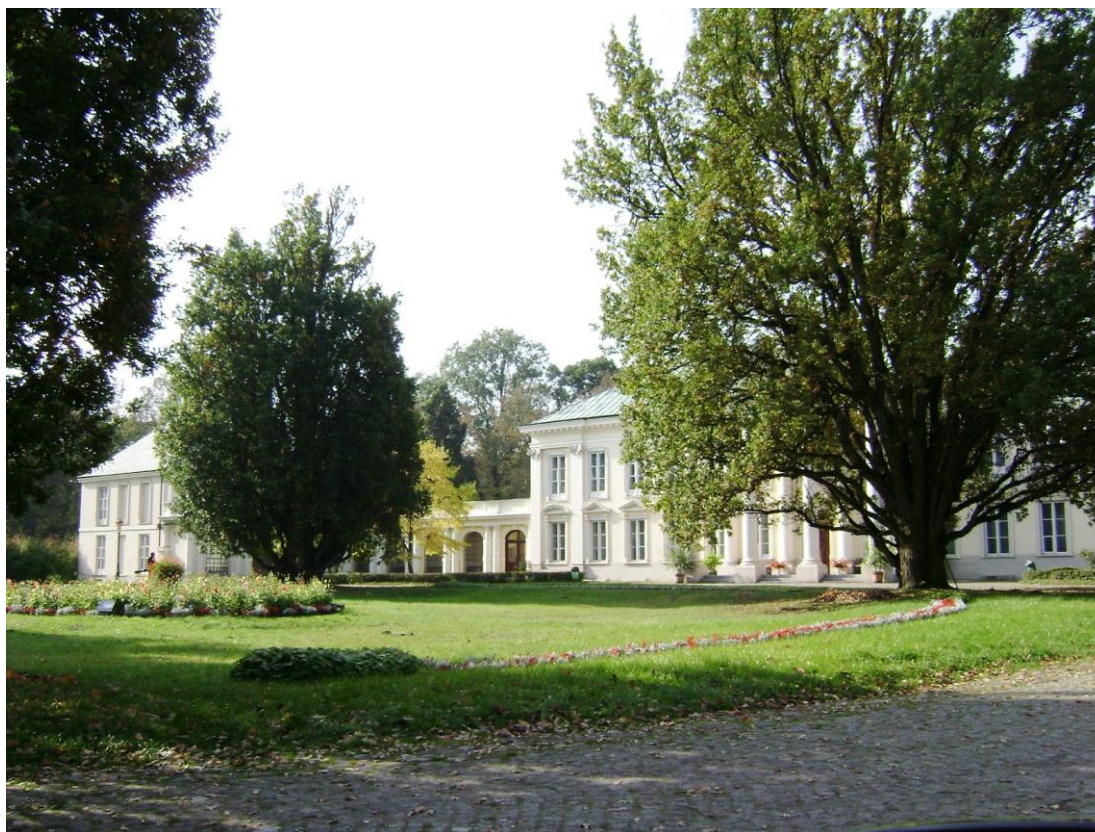
Pałac w Walewicach (fot. M. Siembor)
