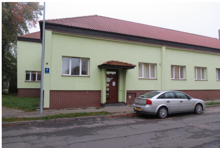
Wejście główne do budynku KOWR
