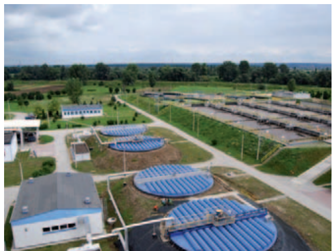
Fot. 8. Oczyszczalnia ścieków w Raciborzu
