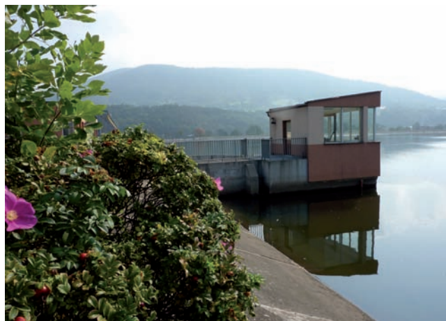
Fot. 6. Zbiornik Czaniec zapora czołowa
