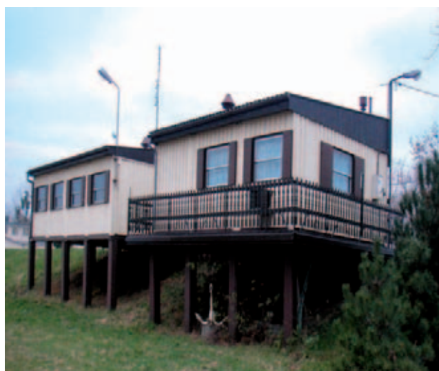
Fot. 7. Stacja w Chałupkach
