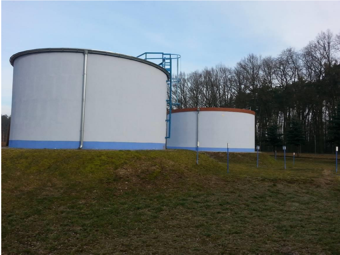
Zbiorniki do magazynowania wody uzdatnionej przy stacji uzdatniania w Trzcielu
