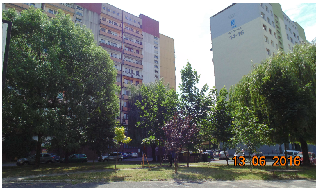
Fot. 2. Rejon badań, widok w kierunku wschodnim
