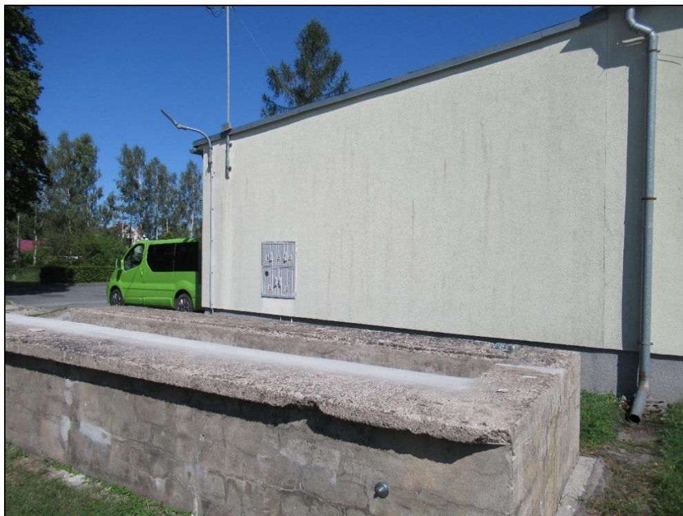
Zdjęcie nr 7. Budynek nr 2 i 3, fasada ściany nr 3 i 4. Ściany lokalnie zabrudzone, malowane w kolorach jasnych. Wbudowana w ścianę rozdzielnica elektryczna i napowietrzny przyłącz elektroenergetyczny.
