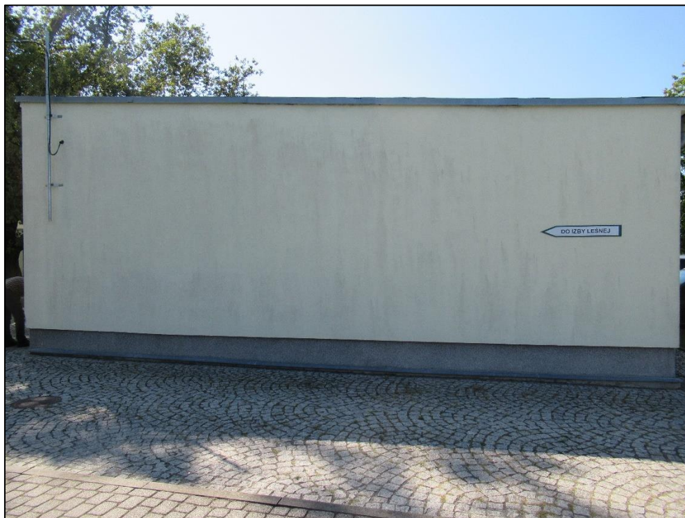
Zdjęcie nr 10. Budynek nr 3, fasada ściany nr 6. Wspornikowy przyłącz teletechniczny. Zabrudzenia na ścianie. Kostka granitowa przy ścianie.
