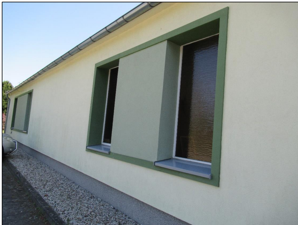
Zdjęcie nr 10. Budynek nr 3, fasada ściany nr 6. Wspornikowy przyłącz teletechniczny. Zabrudzenia na ścianie. Kostka granitowa przy ścianie.
