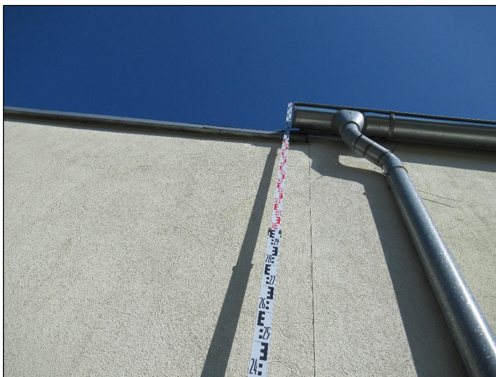
Zdjęcie nr 8. Budynek nr 2, fasada ściany nr 3 i 4. Pionowa dylatacja ścian bez uszczelniania.
