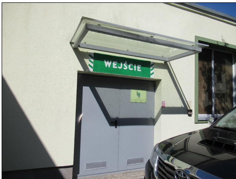
Zdjęcie nr 14. Budynek nr 3, fasada nr 7. Przy bramie wyłącznik przeciwpożarowy i wspornikowy daszek szklany.
