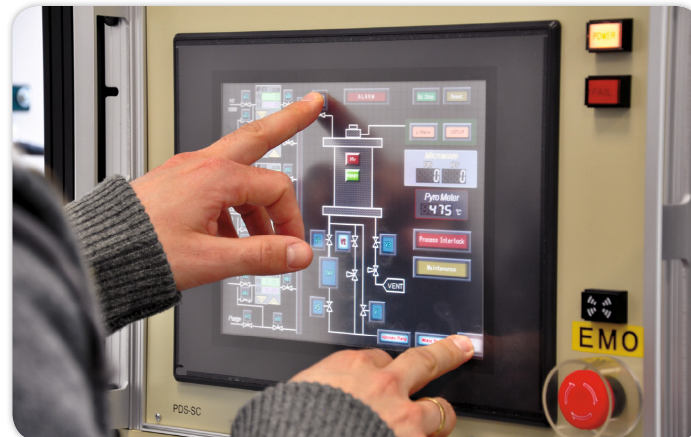
Panel sterujący technologicznego systemu plazmowego do syntezy warstw diamentowych.
