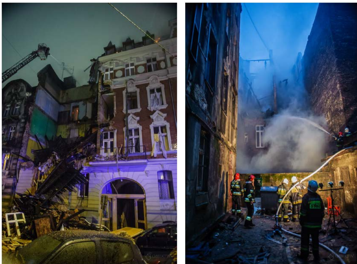
Fot. III. 9. Podawania prądów gaśniczych podczas katastrof budowlanych
