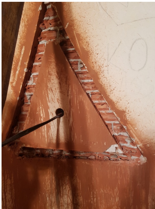
Fot. VI. 10. Wykonanie przebicia w ścianie o dużej grubości – wykonanie bruzdy (2)
