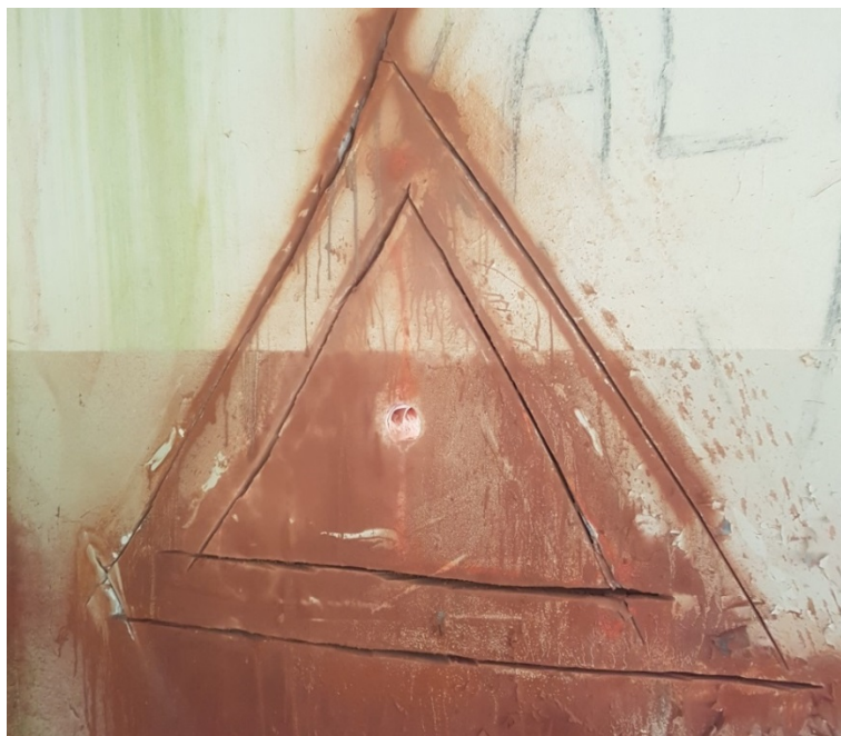
Fot. VI. 9. Wykonanie przebicia w ścianie o dużej grubości – podwójne nacięcie (1)
