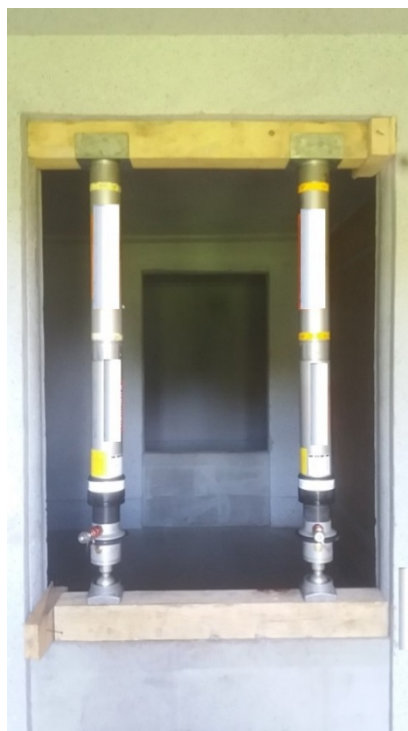
Fot. V. 4. Podpora zabezpieczająca otwór okienny
