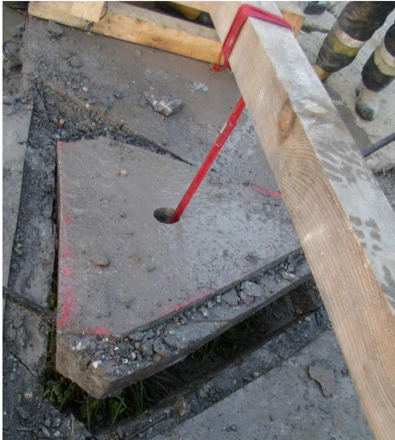
Fot. VI. 15. Podwieszenie wycinanego elementu stropu
