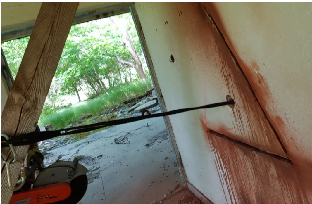
Fot. VI. 7. Zabezpieczenie wycinanego elementu
