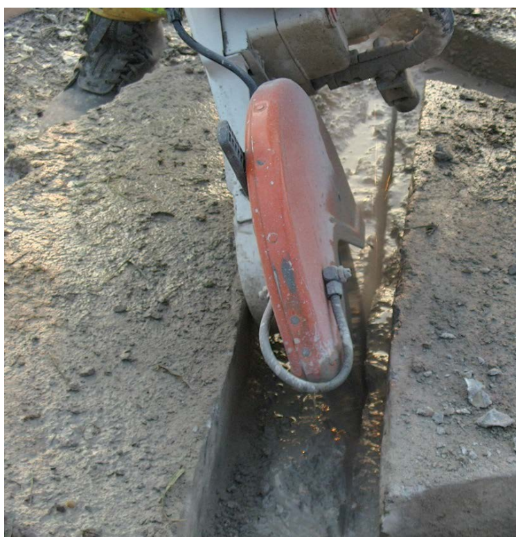
Fot. VI. 14. Wykonanie przebicia w stropie o dużej grubości – docięcie otworu (3)
