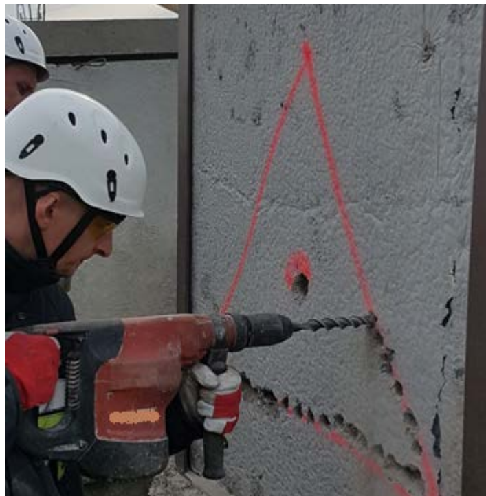
Fot. VI. 4. Nawiercenie otworów
