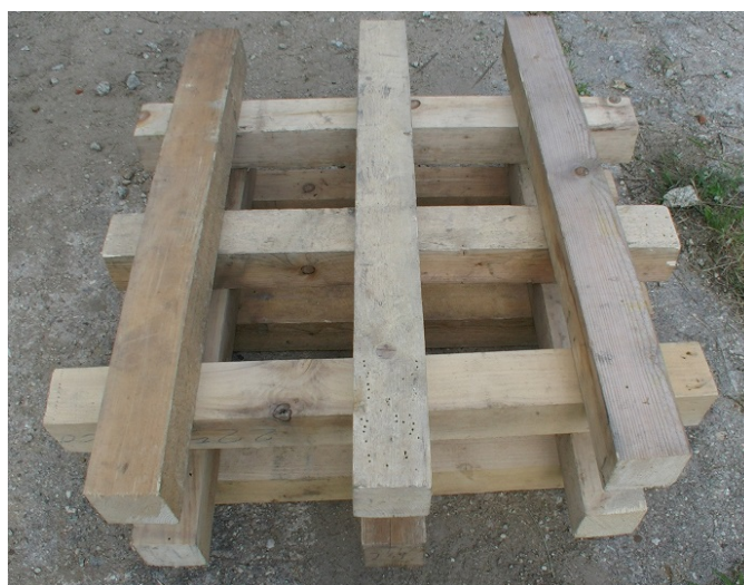
Fot. V. 6. Podpora typu „bezgwoździowego”
