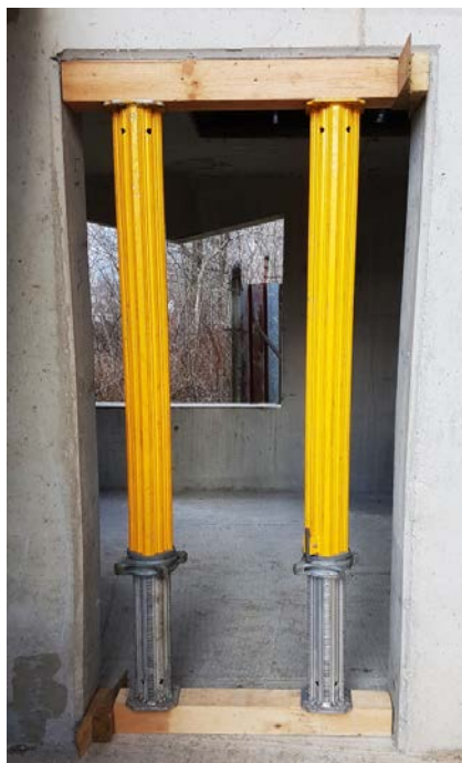
Fot. V. 3. Podpora zabezpieczająca otwór drzwiowy
