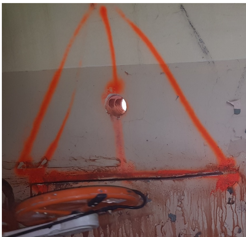
Fot. VI. 5. Kolejność wykonywania cięć
