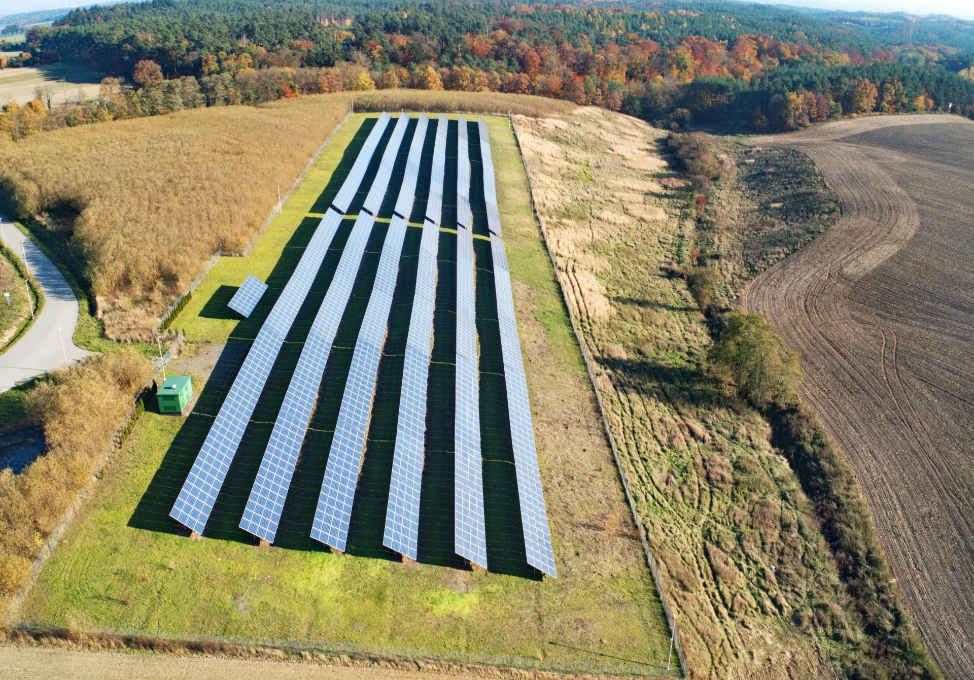
Elektrownia PV w Stanowicach (fot.: Jacek Fedorowicz)
