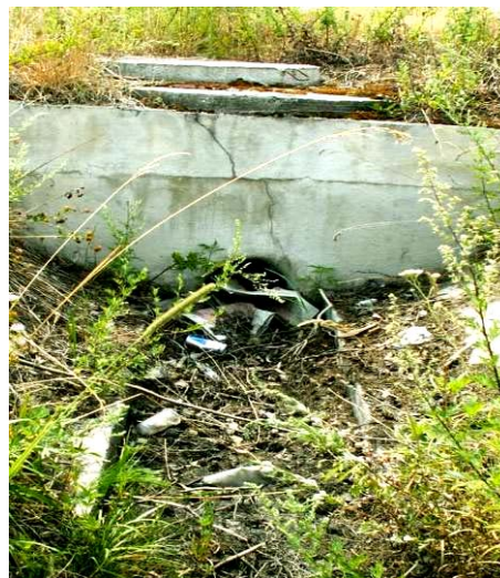
Fot. 2.2. Zatkany wlot do piaskownika i separatora
