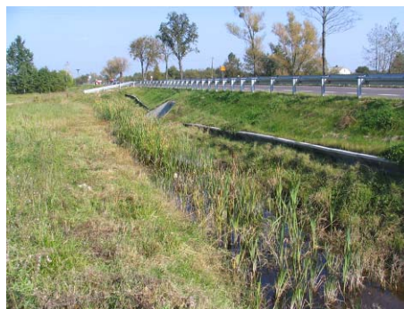
Fot. 2.12. Rów infiltracyjny - droga Lublin-Dorohusk
