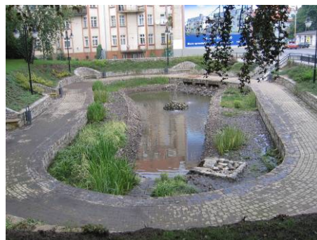
Fot. 2.19. Zbiornik retencyjny wód deszczowych o kilku poziomach retencji i walorach ozdobnych – Sopot, ul. Kochanowskiego
