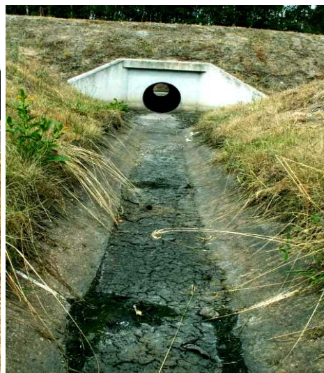
Fot. 2.4. Brak urządzeń do wylapywania zawieszin oraz większych odpadów
