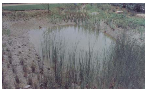
Fot. 2.10. Staw infiltracyjny z roślinnością
