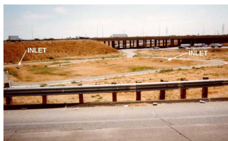
Fot. 2.9. Staw infiltracyjny suchy [39]
