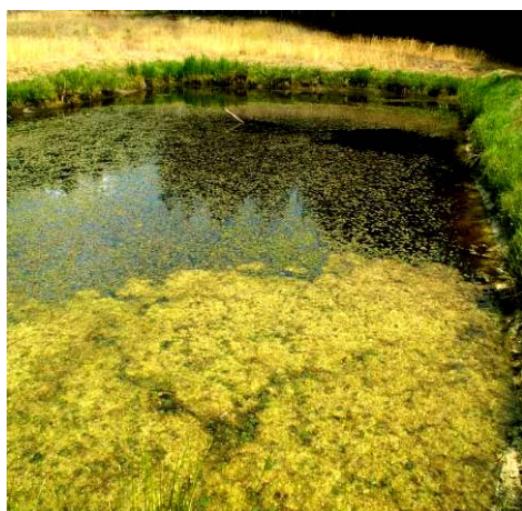
Fot. 2.5. Staw filtracyjny - zła eksploatacja powodująca eutrofizację zbiornika
