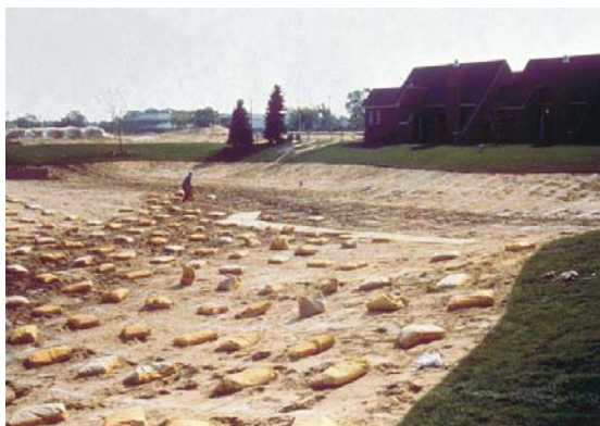
Fot. 2.14. Worki bentonitu rozłożone na powierzchni gruntu z regularnością, odpowiadającą jednostkowej dawce bentonitu
