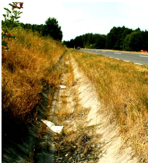
Fot. 2.3. Rów szczelny, który niedługo przekształci się w rów trawiasty
