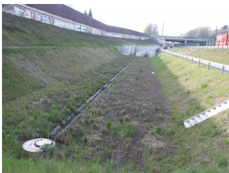
Fot. 2.13. Rozwiązanie mieszane – połączenie stawu retencyjno-infiltracyjnego z filtrem pionowym
