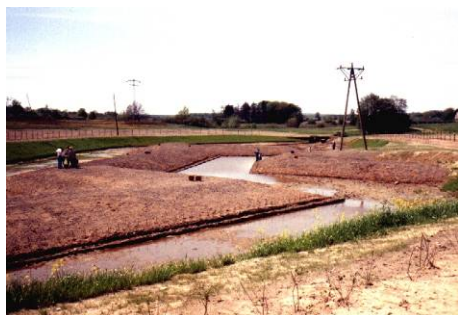
Fot. 2.11. Budowa stawu o rozszerzonej retencji z gozłami filtracyjnymi – Bielkowo, woj. pomorskie
