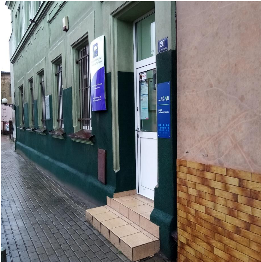
Wejście od ul. Paderewskiego
