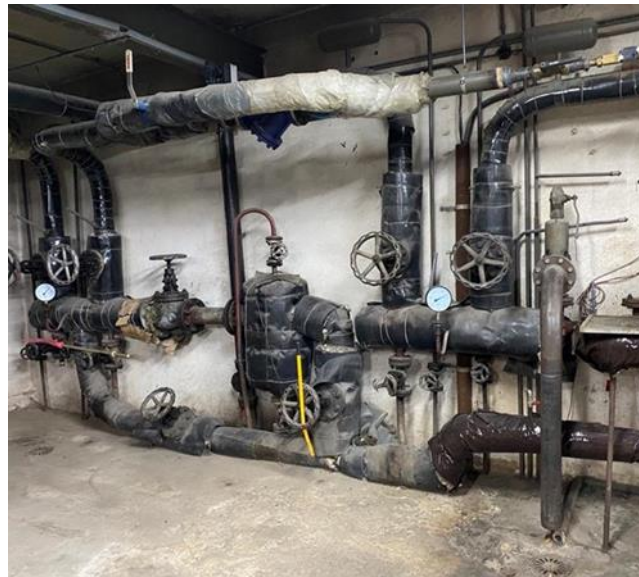
Rys. 2-8 | Węzeł cieplny - przyłącza sieciowe
