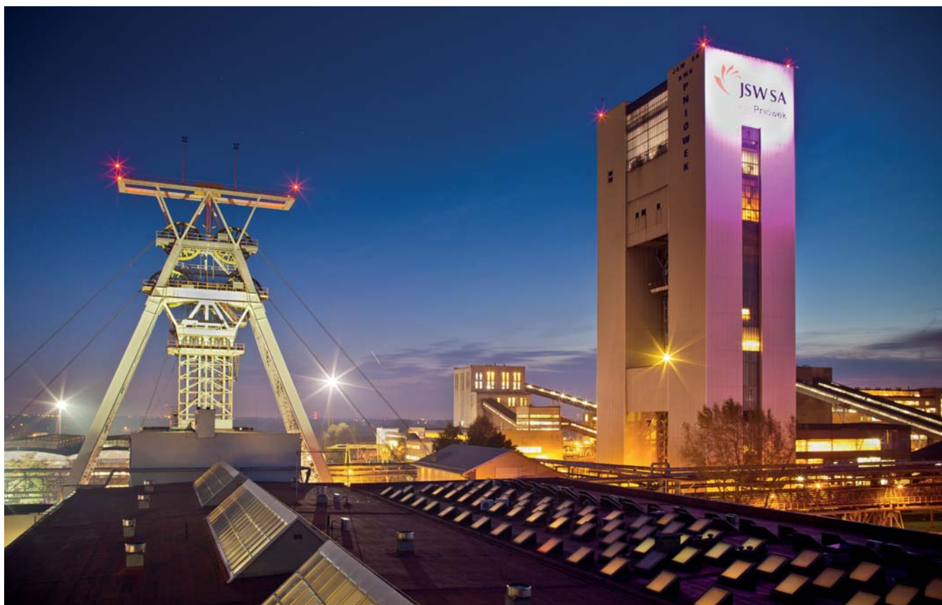
Kopalnia Pniówek – jeden z obiektów, w ramach którego realizowany jest program „Inteligentna kopalnia”.
