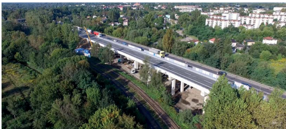
Zmodernizowana estakada w Sosnowcu w ciągu drogi S1
