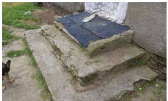
Zły stan techniczny schodów, wady konstrukcyjne – stromizna, brak barierek i poręczy, nierówna powierzchnia stopnic
