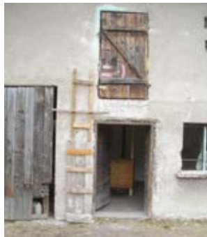
Używanie starych, wyeksplotowanych i nieprawidłowo wykonanych drabin, bez zabezpieczeń przed przechylem, zbyt krótkich, ustawionych na niestabilnym podłożu
