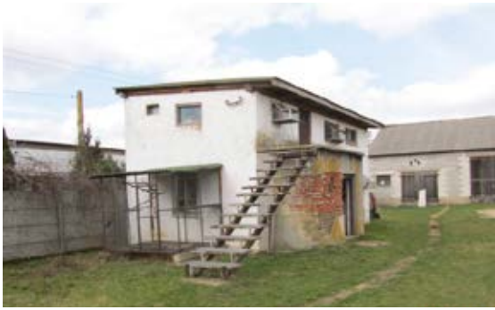
Zły stan techniczny schodów, wady konstrukcyjne – stromizna, brak barierek i poręczy, nierówna powierzchnia stopnic
