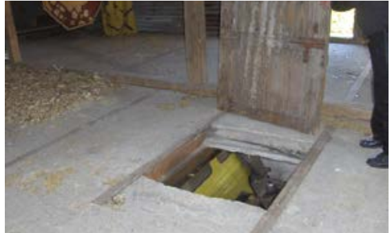
Brak zabezpieczenia strychów i otworów zrzutowych barierkami i poręczami
