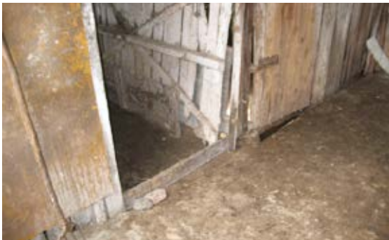
Wady konstrukcyjne budynków – progi w przejściach
