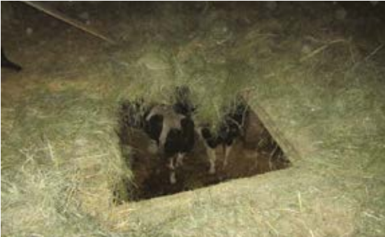
Brak zabezpieczenia strychów i otworów zrzutowych barierkami i poręczami
