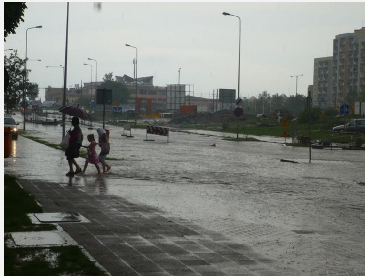
Podtopienie ul. Nowowiejska Elbląg 07.2011
