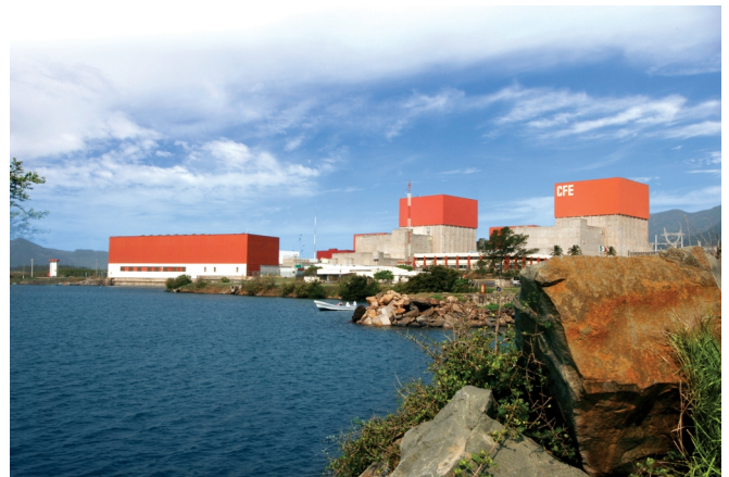
Elektrownia jądrowa Laguna Verde (fot. Wikipedia)
