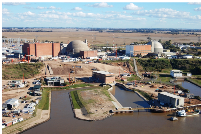
Elektrownia jądrowa Atucha (fot. Wikipedia).
