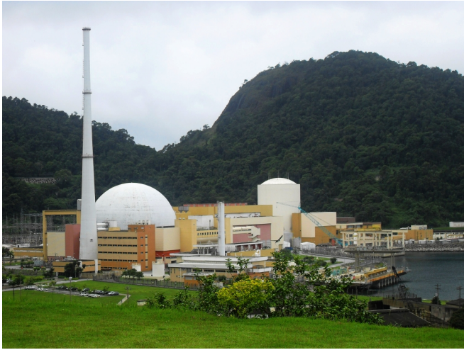
Elektrownia jądrowa ANGRA (fot. Wikipedia).
