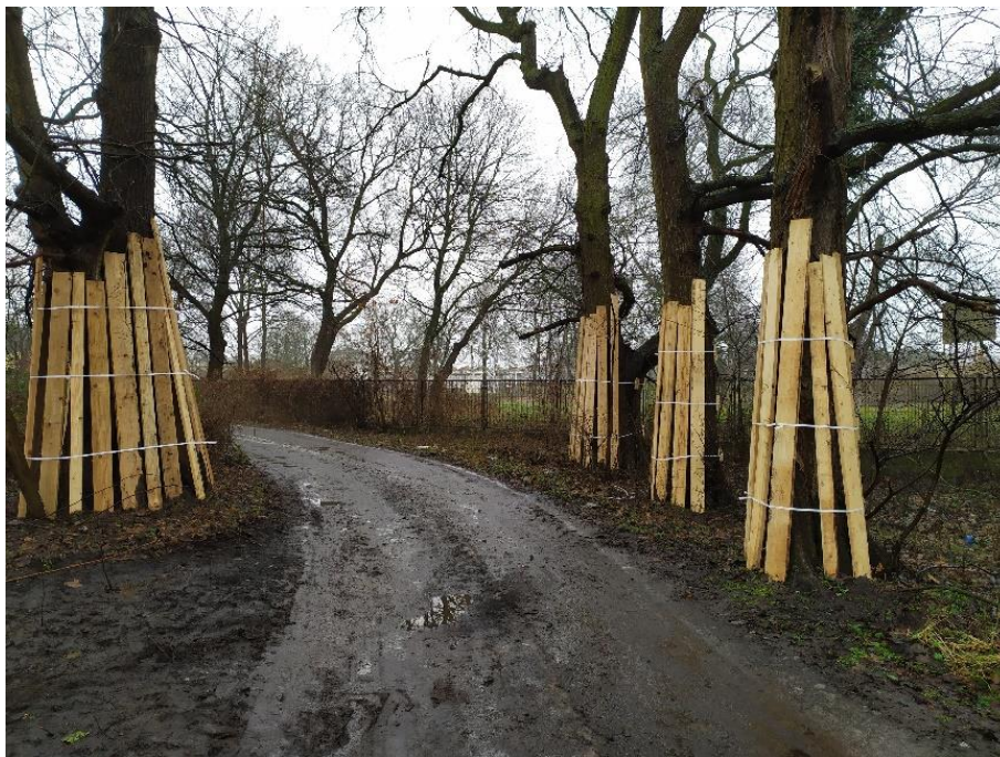
Fot. 3. Zabezpieczenie drzew narażonych na uszkodzenie.
