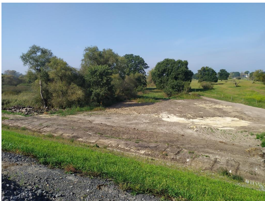
Fot. 14. Zrekultywowany teren placu składowego.
