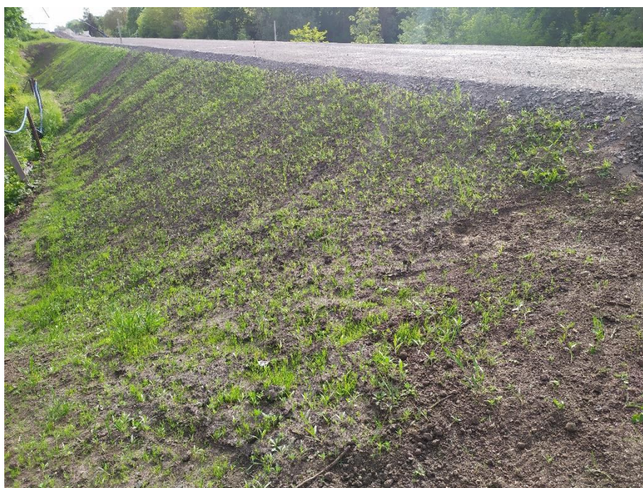
Fot. 12. Nasyp kolejowy – rekultywacja terenu.
