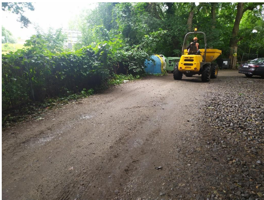
Fot. 11. Kontrola stanu dróg dojazdowych.
