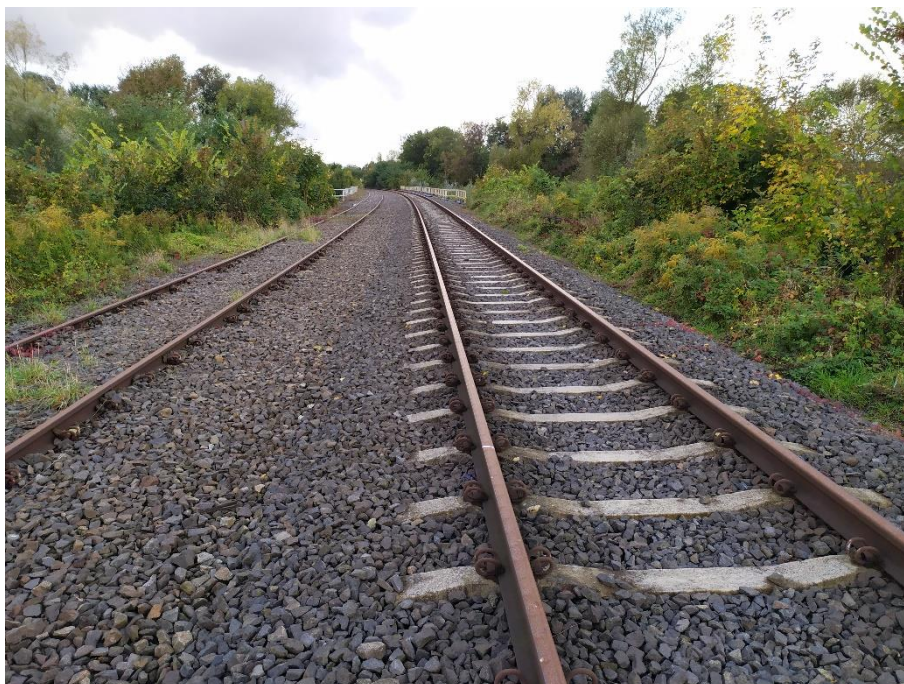
Fot. 1. Torowisko w centralnej części Zadania przed rozpoczęciem robót.
