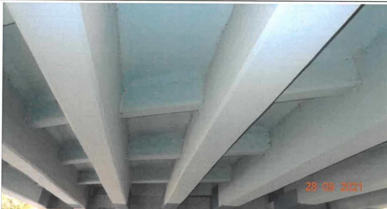
Fot. 8 Widok mostu od spodu
