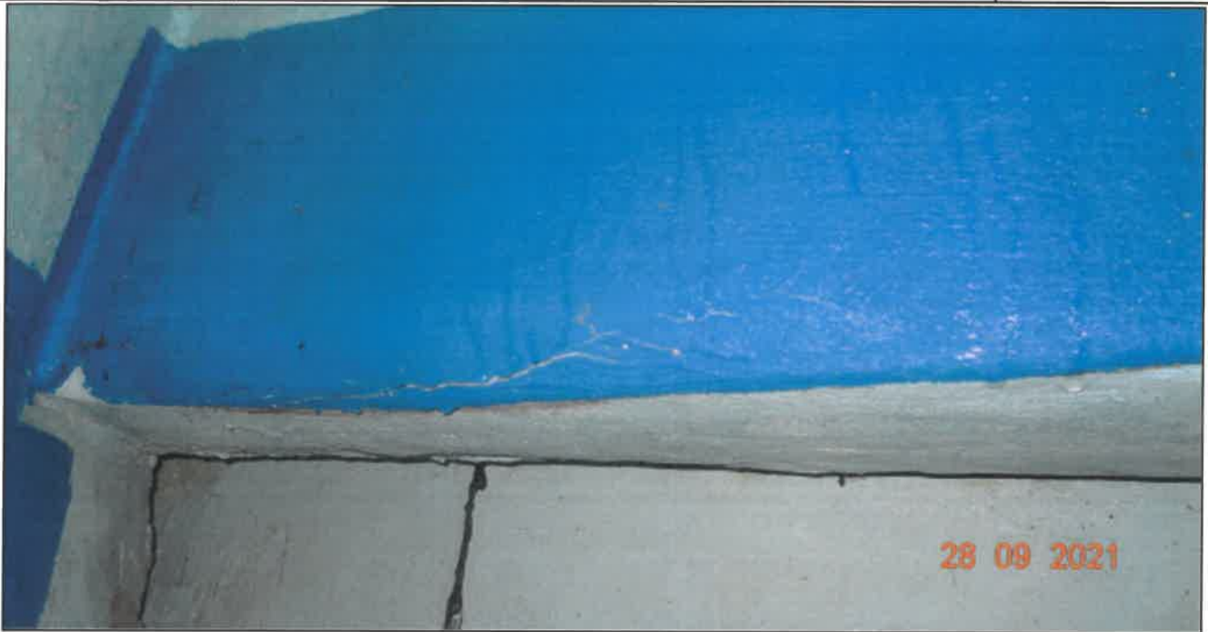
Fot. 48 Konstrukcja dźwigarów głównych Poprzecznicą skrajną pomiędzy dźwigarami nr 5 i nr 6 (przyczółek wschodni) - zarysowania powierzchni poprzecznic (rysy o rozwarości od 0,2 mm do 1,00 mm)
