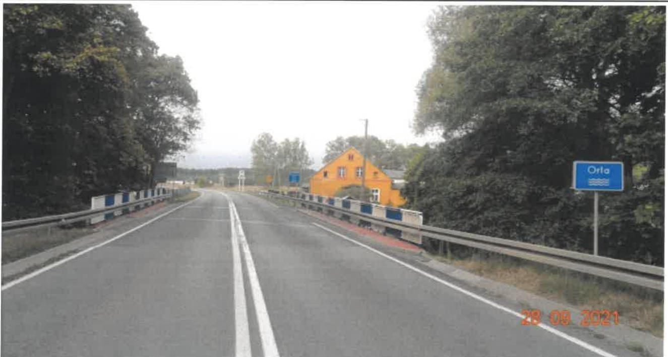
Fot. 2 Widok dojazdu do mostu od strony wschodniej
