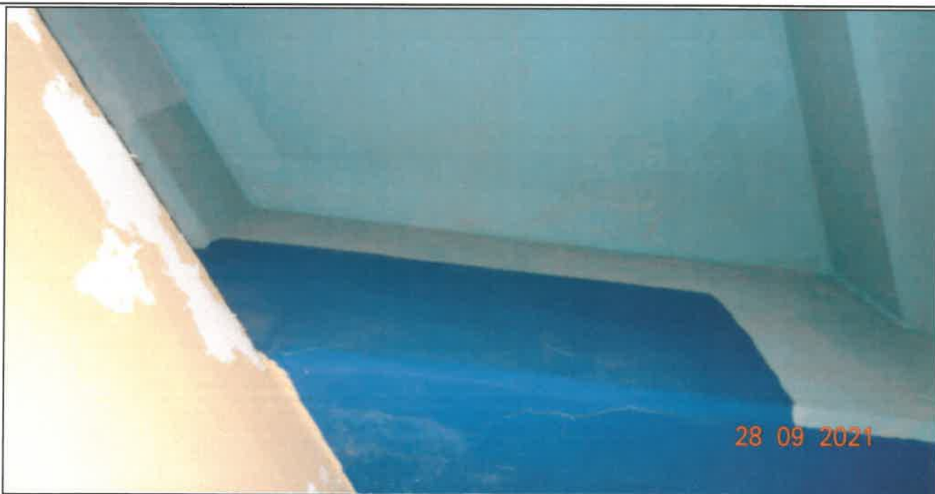
Fot. 47 Konstrukcja dźwigarów głównych Dźwigar nr 5 (przyczółek wschodni) - zarysowania na dolnej powierzchni dźwigara (rysy o rozwarości 0,2 mm ),
