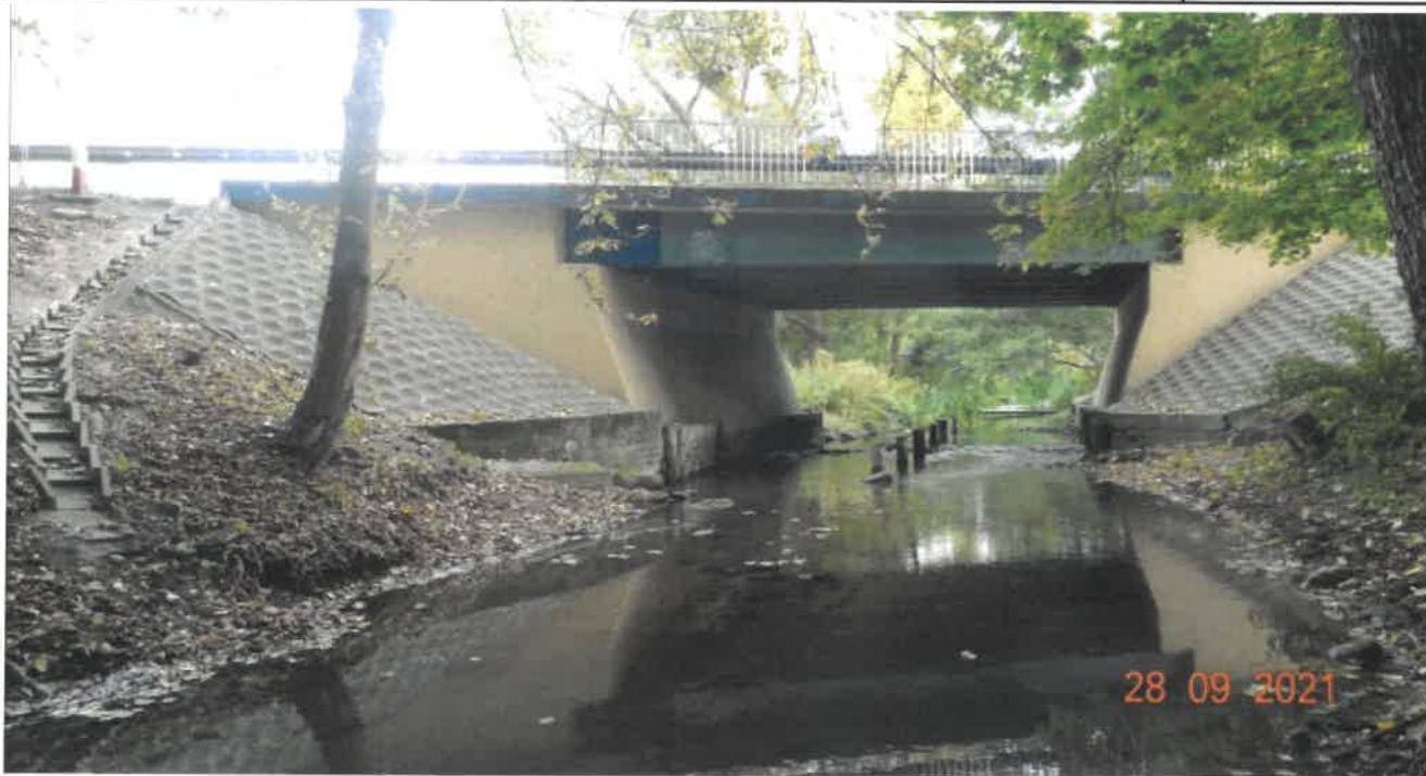
Fot. 7 Widok mostu z boku od strony południowej
