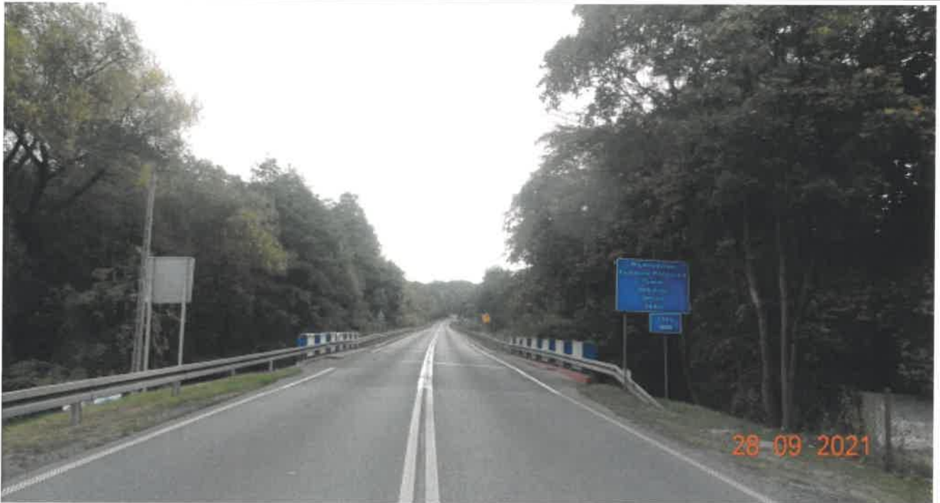
Fot. 1 Widok dojazdu do mostu od strony zachodniej
