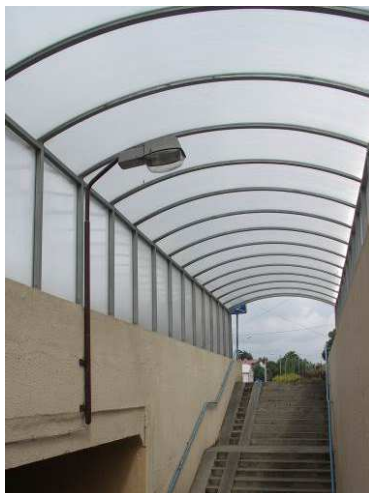
Rys. 3.19. Osłona nad wejściem do przejścia podziemnego w dobrym stanie technicznym
