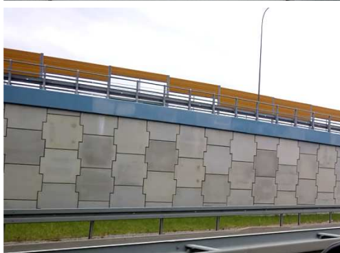
Rys. 5.33. Korpus z elementów prefabrykowanych w dobrym stanie, brak uszkodzeń
