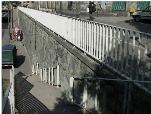
Rys. 5.8. Balustrada na konstrukcji oporowej i schodach w dobrym stanie
