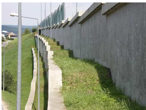
Rys. 5.7. Teren nad i przed konstrukcją bez zastrzeżeń
