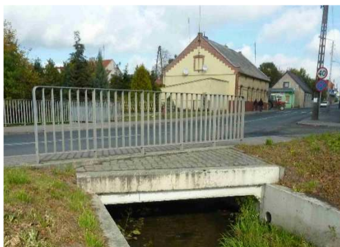
Rys. 4.17. Balustrada szczeblinkowa bez uszkodzeń
