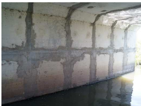
Rys. 4.64. Elementy ramowe prefabrykowane przepustu skrzynekowego dwudzielnego bez uszkodzeń. Lokalnie występują niewielkie zanieczyszczenia
