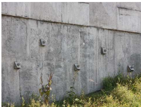
Rys. 5.60. Zakotwienia kotew gruntowych bez zastrzeżeń
