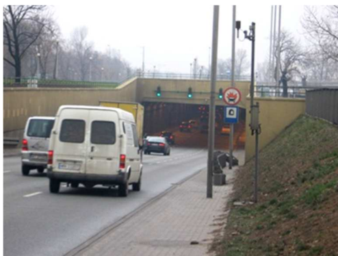
Rys. 3.5. Skarpy przy wjeździe do tunelu właściwie zabezpieczone i utrzymane
