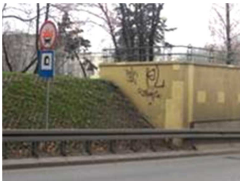
Rys. 3.1. Skarpy przy wjeździe do tunelu właściwie zabezpieczone i utrzymane
