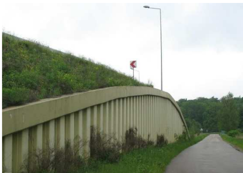
Rys. 5.38. Konstrukcja oporowa bez uszkodzeń
