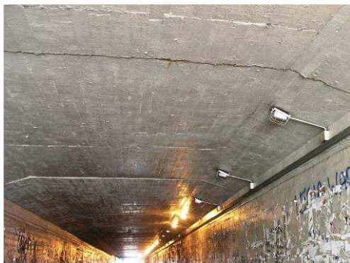
Rys. 3.38. Strop przejścia podziemnego w dobrym stanie, jedynie niewielkie, miejscowe zanieczyszczenia
