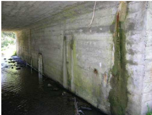
Rys. 4.42. Widoczne przecieki, korozja betonu (łuszczenie), wegetacja roślin (mchu) na ścianie przepustu ramownicowego
