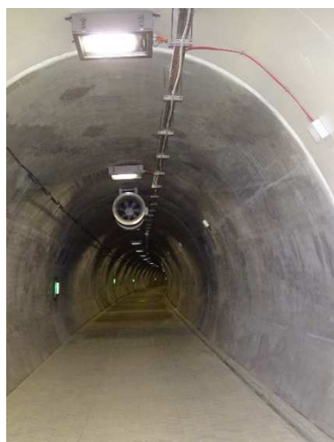
Rys. 3.99. Stan zamocowań i osłon instalacji telekomunikacyjnej/światłowodowej bez zastrzeżeń
