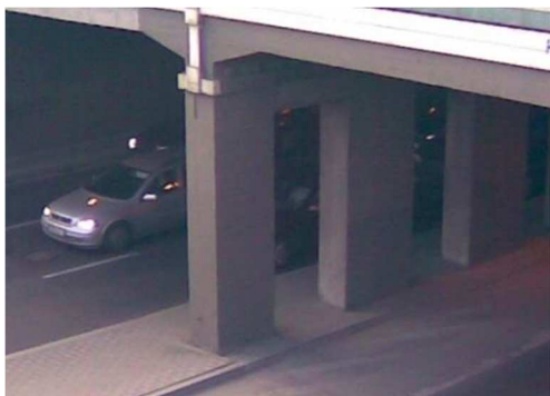
Rys. 3.44. Podpory w tunelu w stanie dobrym
