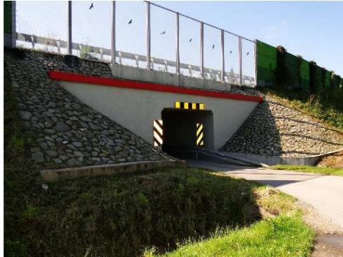
Rys. 3.87. Ekran nad wjazdem do tunelu bez uszkodzeń
