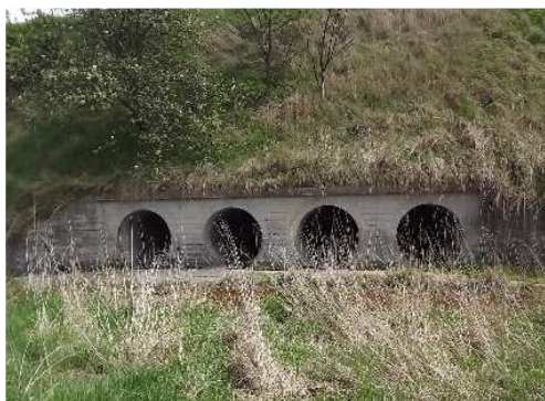
Rys. 4.3. Bujna wegetacja na skarpie zagrażająca jej trwałości
