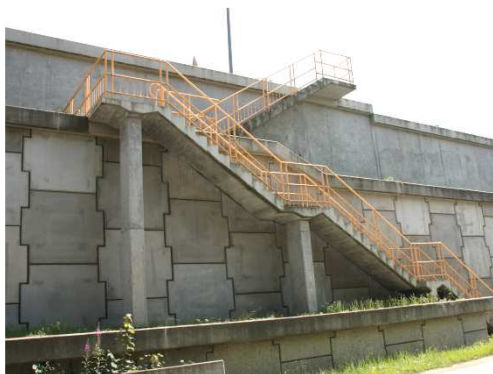
Rys. 5.56. Schody przy konstrukcji oporowej bez uszkodzeń
