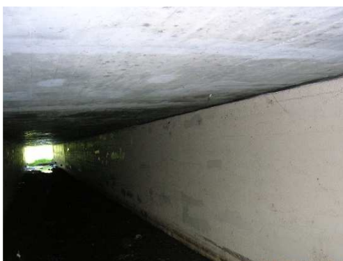
Rys. 4.46. Ściany boczne przepustu bez uszkodzeń. Występują niewielkie (do 5%) zanieczyszczenia obniżające estetykę
