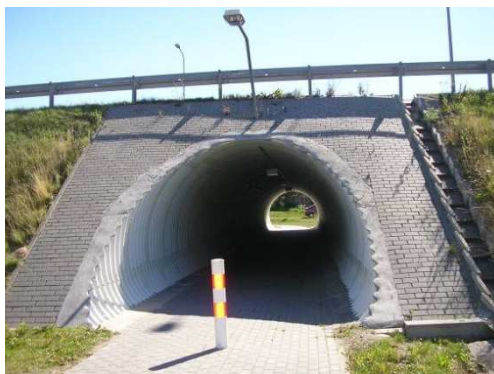
Rys. 3.46. Przejście podziemne o konstrukcji gruntowo-powłokowej o przekroju zamkniętym. Stan fundamentu niewzbudzający zastrzeżeń, brak osiadań oraz deformacji konstrukcji i innych ewentualnych uszkodzeń spowodowanych złym stanem fundamentu
