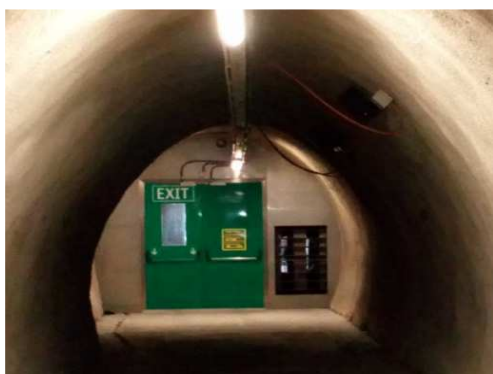
Rys. 3.104. Wyjście do tunelu ewakuacyjnego bez zastrzeżeń, odpowiednie oznakowanie i oświetlenie
