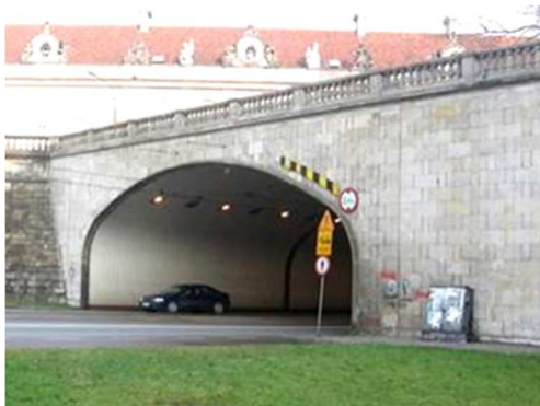
Rys. 3.27. Ściana czołowa w dobrym stanie technicznym, nieliczne zanieczyszczenia i wykwyty
