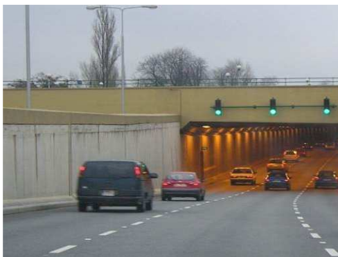
Rys. 3.49. Niewielkie (nieprzekraczające 5% powierzchni) przecieki wody na ścianie oporowej
