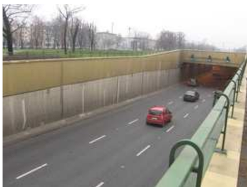
Rys. 3.20. Balustrada na konstrukcji oporowej przy wjeździe do tunelu w dobrym stanie technicznym
