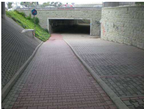
Rys. 3.81. Pochylnia w dobrym stanie, bez uszkodzeń i zanieczyszczeń
