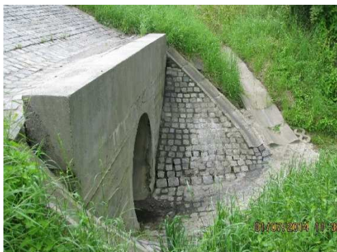
Rys. 4.30. Elementy odwodnienia przepustu bez uszkodzeń, początki wegetacji na ściekach skarpowych
