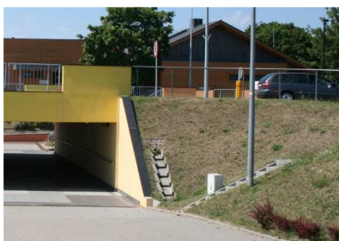
Rys. 3.65. System odwodnienia przejścia podziemnego bez zastrzeżeń
