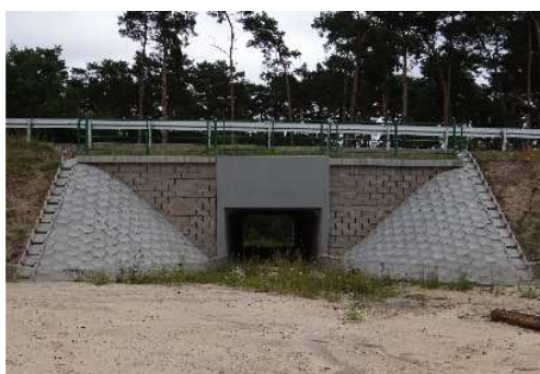
Rys. 4.77. Przepust ramowy z głowicą z gruntu zbrojonego bez uszkodzeń
