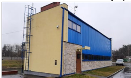
40 Budynek pompowni z zapleczem socjalnym
