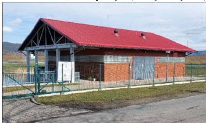
22 Budynek pompowni z zapleczem socjalnym (nowy budynek)
