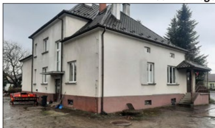
37 Budynek Zespołu Wsparcia Technicznego
