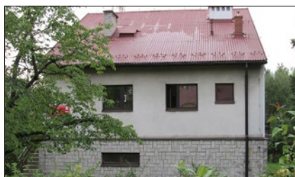
14 Budynek biurowy nr 1
