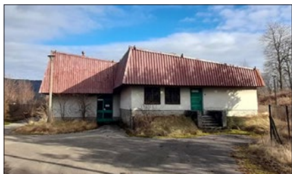
28 Budynek socjalno - warsztatowy
