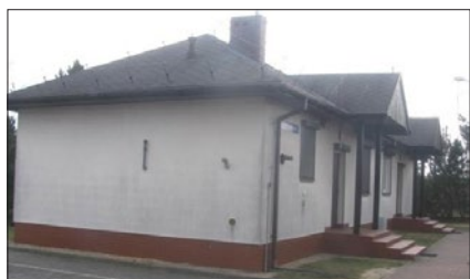
7 Budynek administracyjno - socjalny
