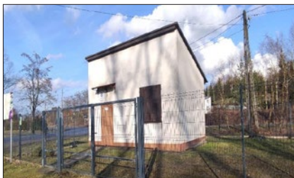
26 Budynek socjalno - warsztatowy
