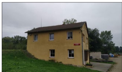
4 Budynek sterowni pochylni
