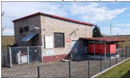
23 Budynek pompowni z zapleczem socjalnym (stary budynek)
