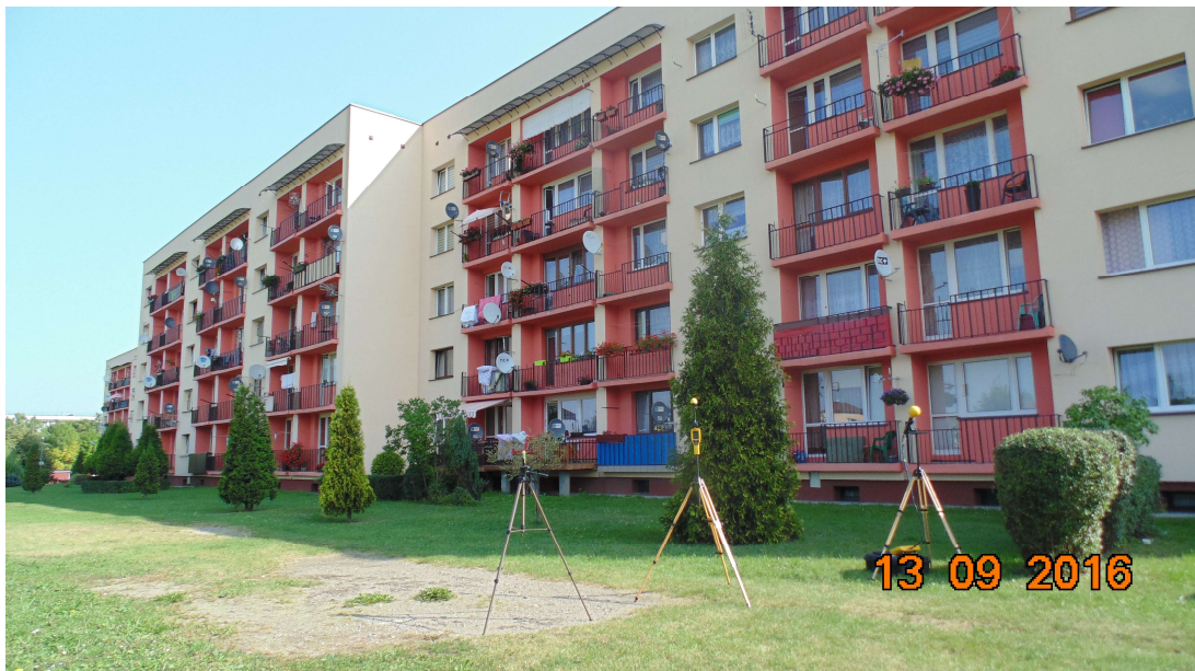
Fot. 2. Rejon badań, widok w kierunku północno - wschodnim
