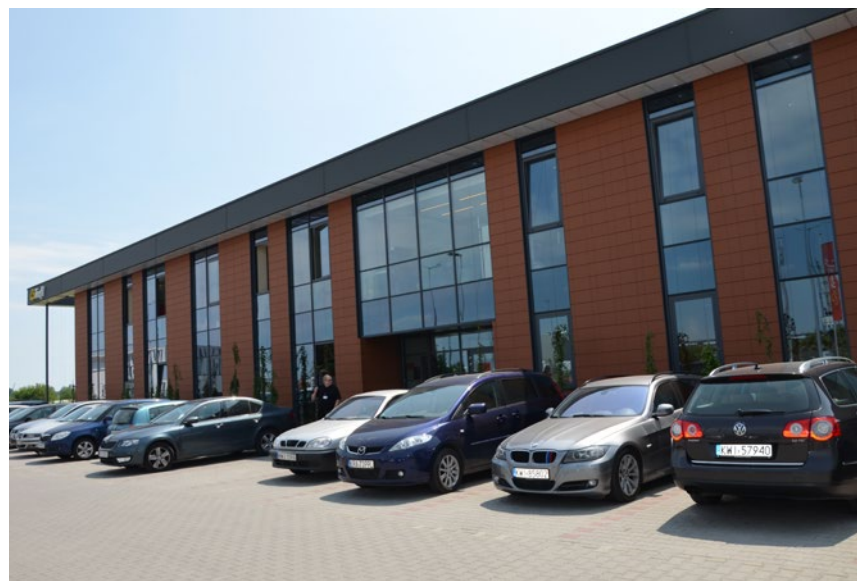
Trefl – fabryka kart zbudowana na gruntach KOWR
