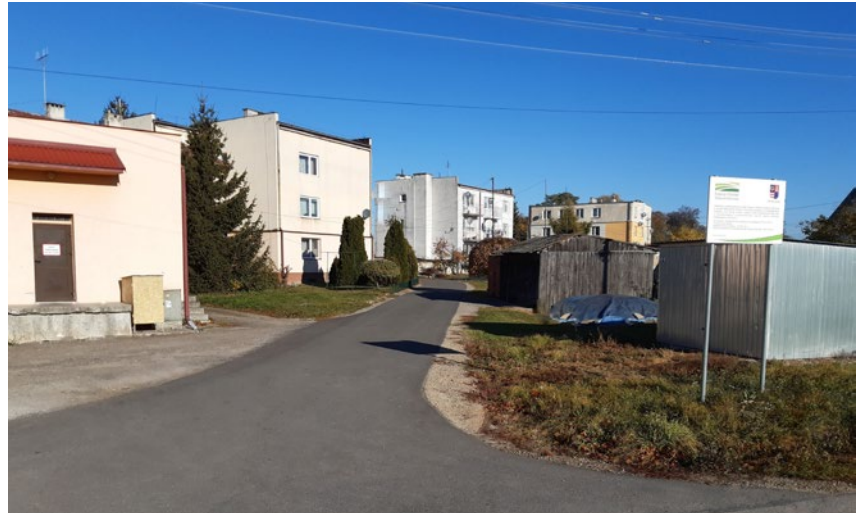
Przebudowana droga we Włostowie
