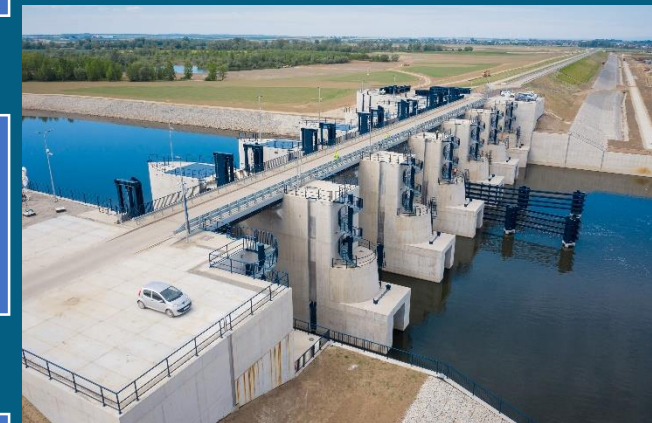
Zbiornik Racibórz Dolny. Widok z góry na budowlę przelewowo-spustową. Fot. Wody Polskie
