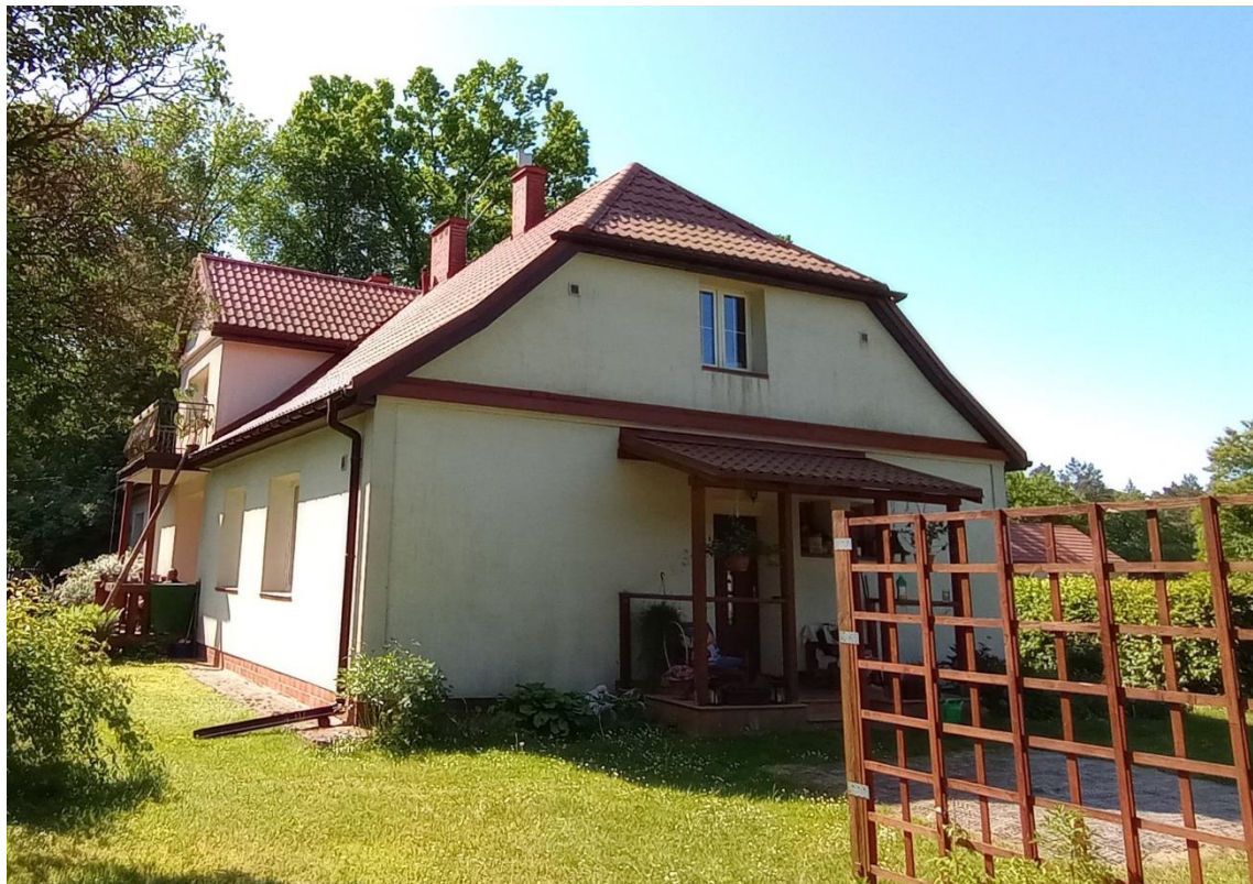
Fot. 1 Budynek mieszkalny – elewacja boczna i frontowa
