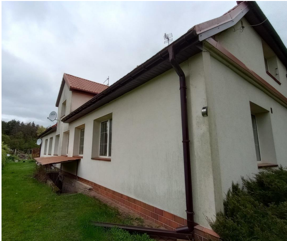
Fot. 3 Budynek mieszkalny – elewacja tylna
