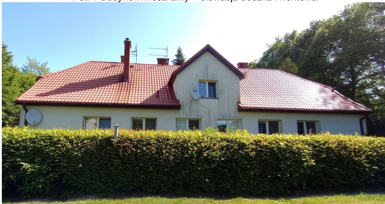
Fot. 2 Budynek mieszkalny – elewacja tylna
