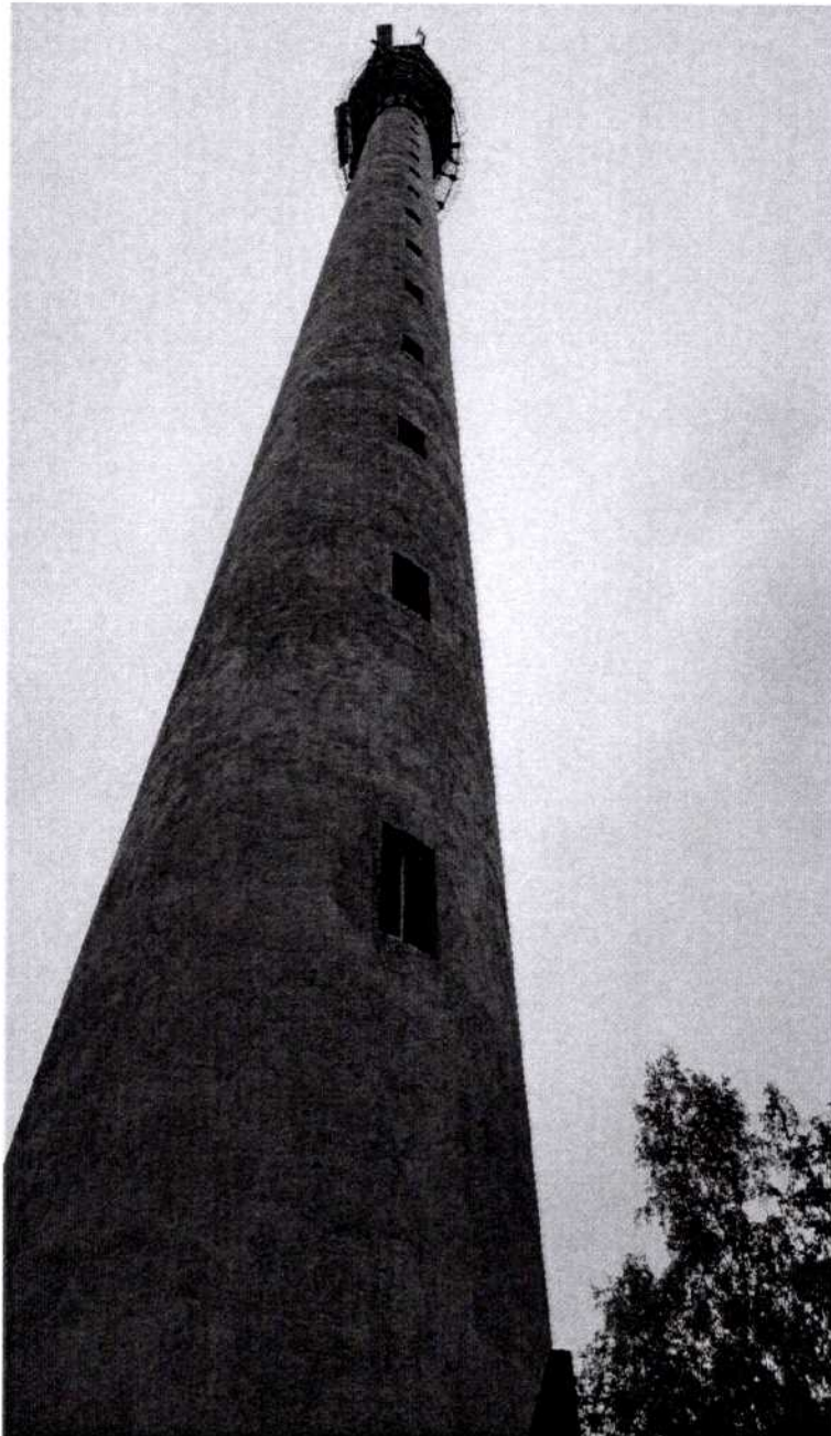
Fot.1 Widok na wieżę (dostrzegalnie)
