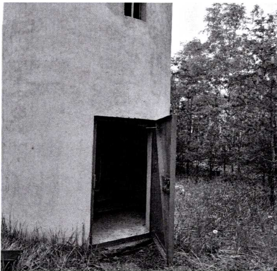
Fot.2 Widok wejście główne do wieży
