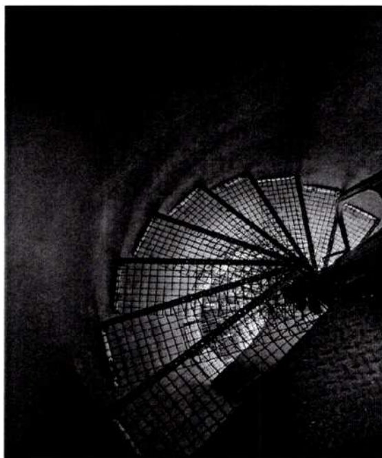
Fot.3 Widok na wewnętrzne schody spiralne
