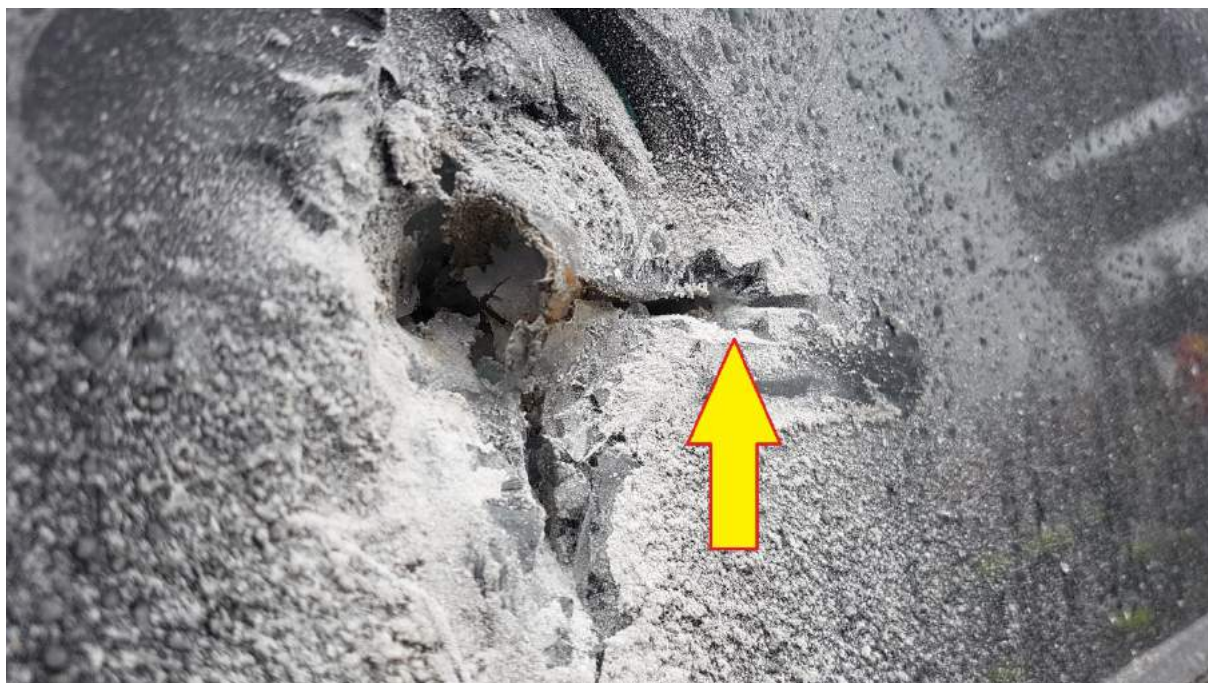
Rys. 463. Niewielkie przecięcie uzyskane przy pomocy piły szablastej
