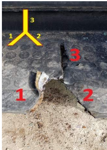
Rys. 411. Nacięcie w podłodze w literę Y
