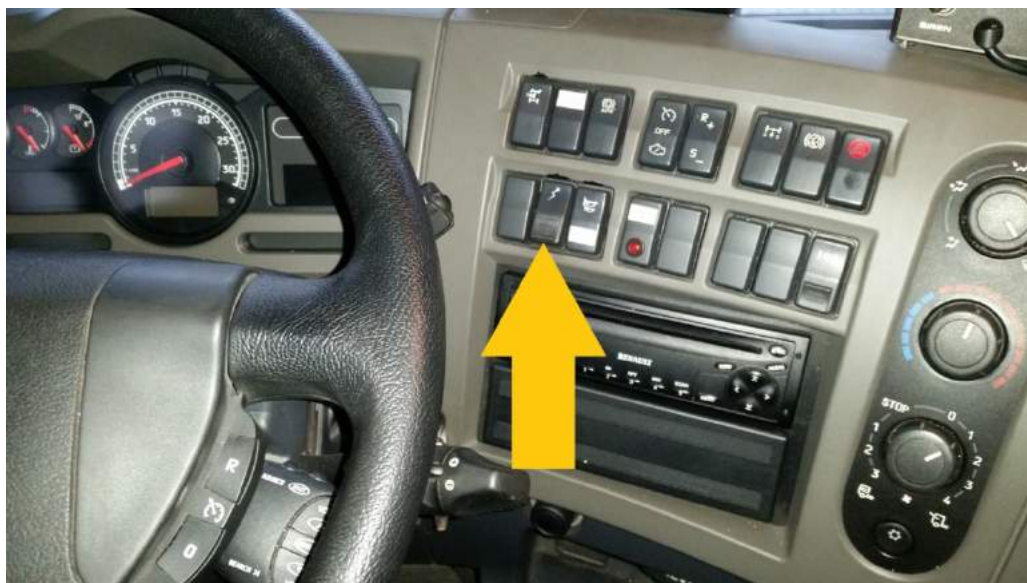
Rys. 94. Główny wyłącznik prądu umieszczony na desce rozdzielczej
