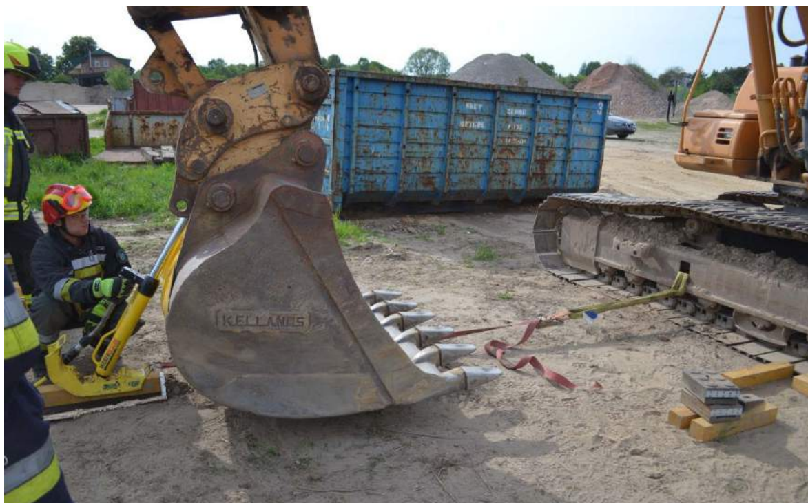
Rys. 389. Pchanie łyżki koparki. Tu widoczne ustabilizowanie pasem transportowym, zapobiegającym ślizganiu się cylindra rozporającego
