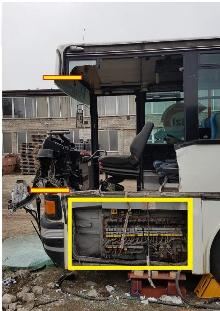
Rys. 413. Miejsca nacięć w przypadku wzmocnionej konstrukcji kratownicowej, występującej poniżej wewnętrznej podłogi użytkowej
