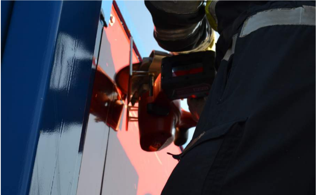
Rys. 348. Wycięcie otworu w tylnej ścianie kabiny przy pomocy piły tarczowej lub piły szablastej
