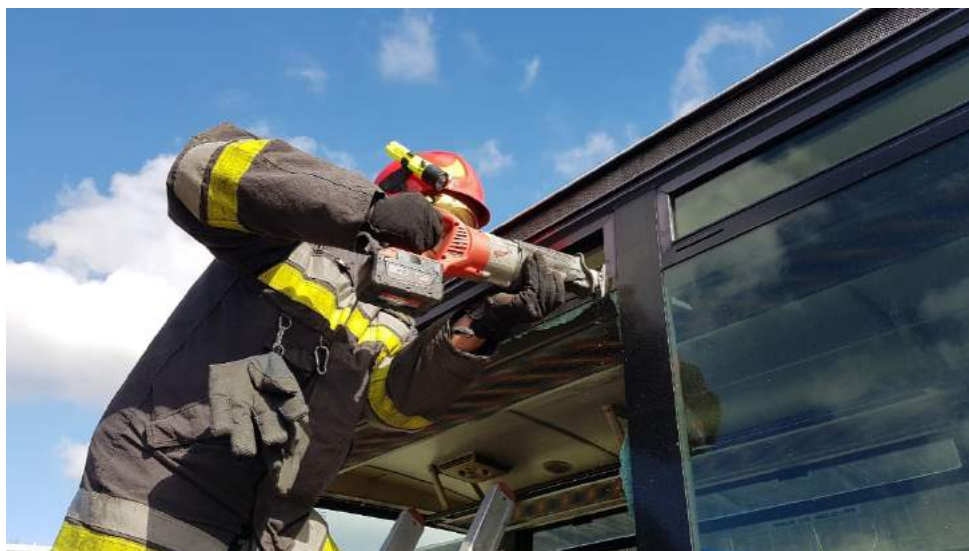
Rys. 407. Cięcie profili okiennych piłą szablą
