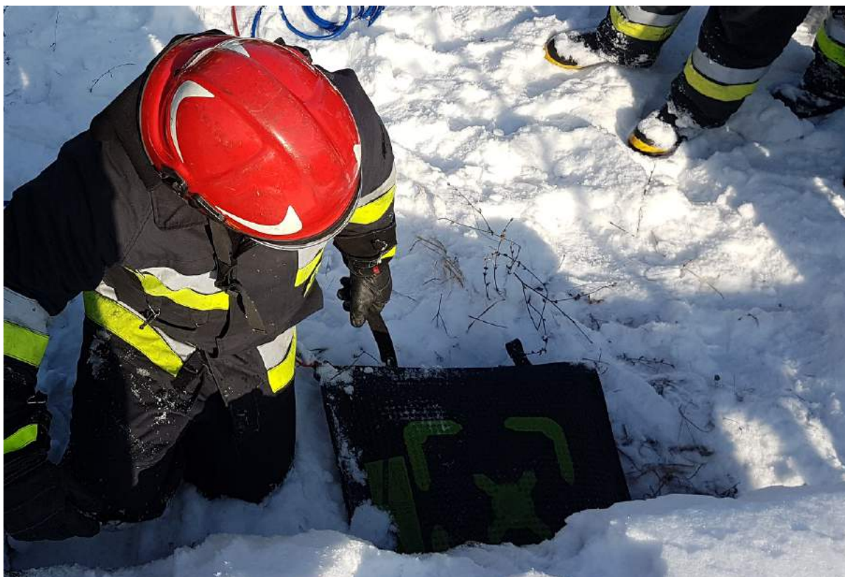
Rys. 48. Widoczne zaznaczenie (zielona, prostokątna ramka) niewybrzuszającej się części poduszki podnoszącej płaskiej. Moment umieszczania poduszki pod elementem
