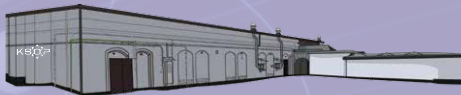
budynek Krajowego Składowiska Odpadów Promieniotwórczych
