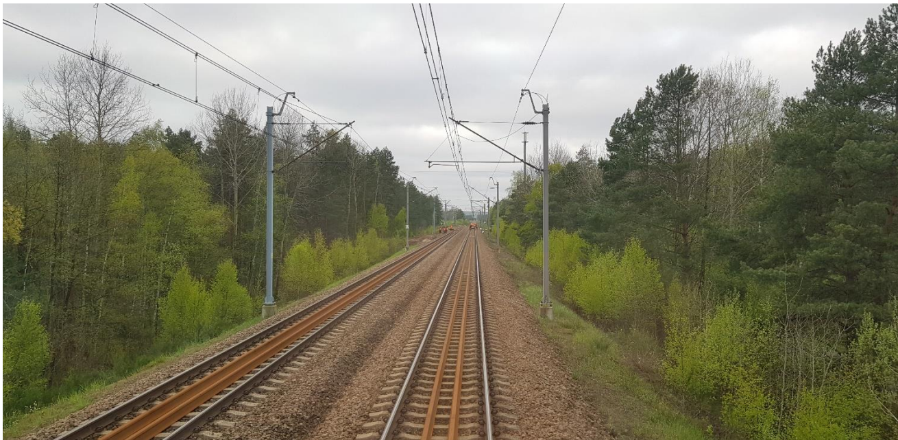
Zdjęcie 1 – źródło: zdjęcie wykonane przez maszynistę poc. 14001.
