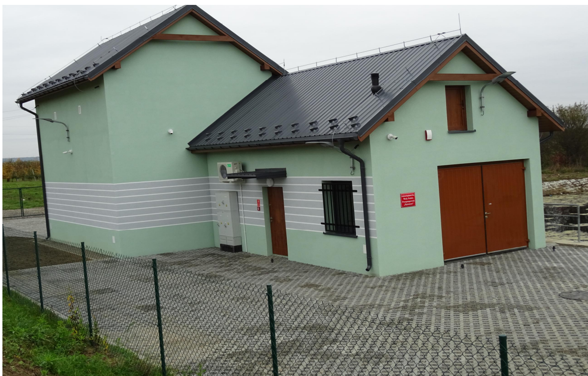
Fotografia 12. Podzadanie 6 - Zrealizowana budowa budynku przepompowni w m. Zajeziorko – widok ogólny (źródło: materiały własne PGW WP).
