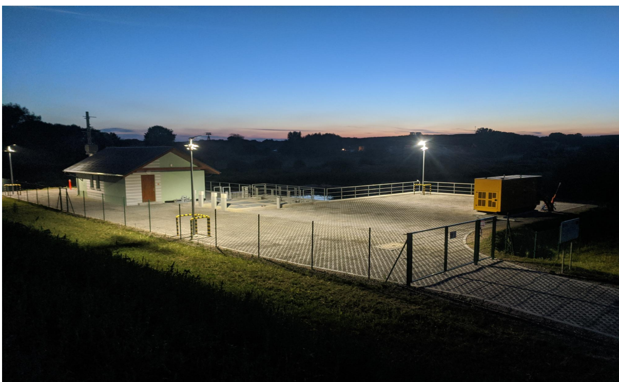
Fotografia 11. Podzadanie 5 - Zrealizowana budowa przepompowni w m. Szewce – widok ogólny (źródło: materiały własne PGW WP).
