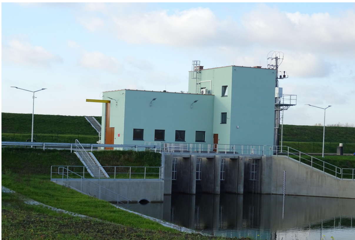
Fotografia 6. Podzadanie 1 - Zrealizowana budowa przepompowni w m. Koźmierów – widok ogólny (źródło: materiały własne PGW WP).
