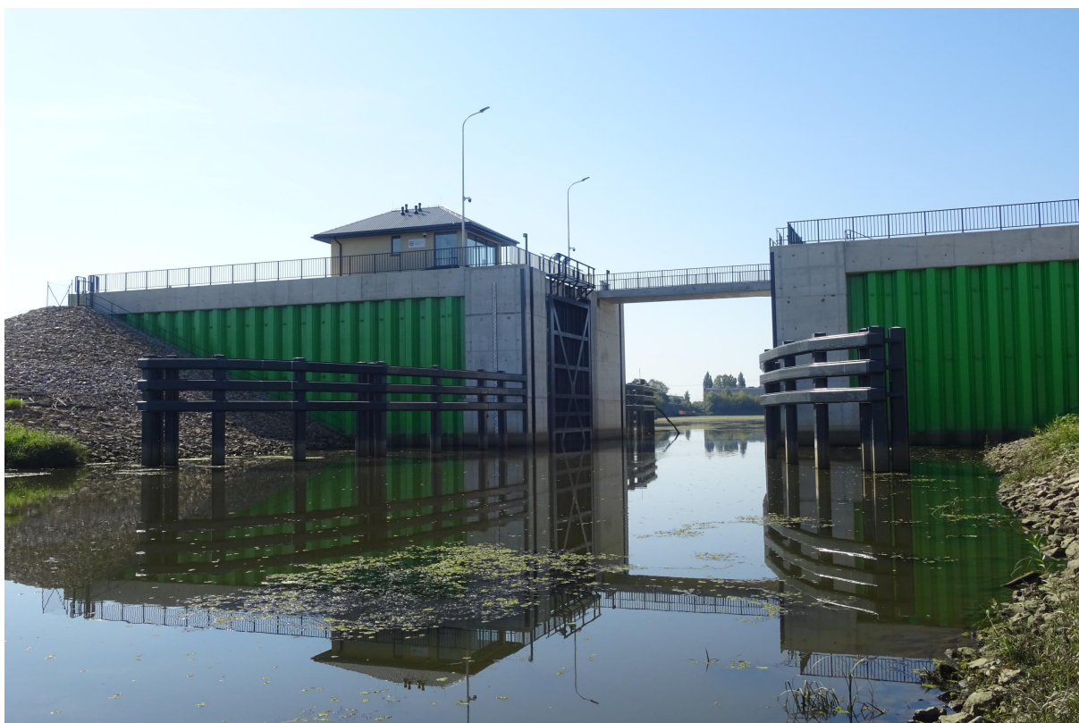
Fotografia 9. Podzadanie 3 - Zrealizowana budowa bramy przeciwpowodziowej w Sandomierzu – widok ogólny (źródło: materiały własne PGW WP).
