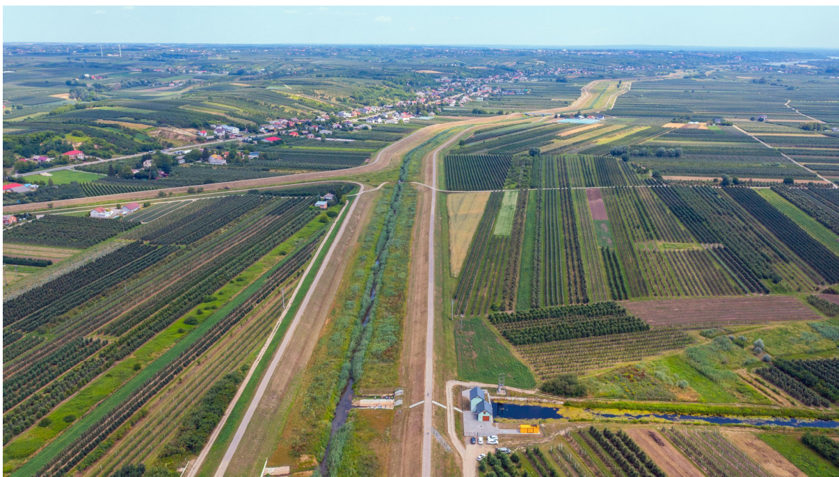
Fotografia 10. Podzadanie 4 - Zmodernizowane wały rzeki Koprzywnianki – widok z lotu ptaka (źródło: materiały własne PGW WP).
