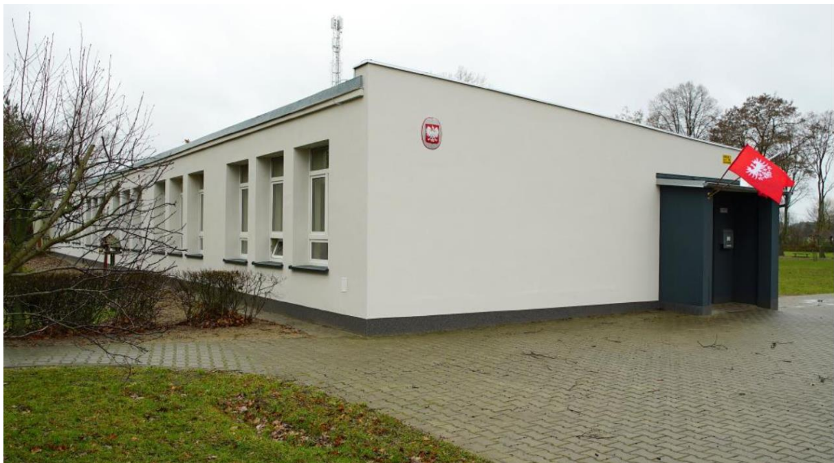
Zdjęcie nr 14. Budynek Szkoły Podstawowej należącej do Zespołu Szkoły Podstawowej i Przedszkola w Chobienicach 145, 64-214 Chobienice
