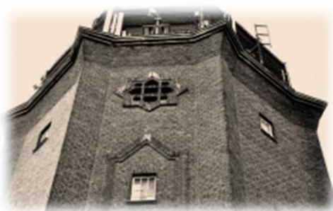
Fot. 93. Zabytkowa wieża ciśnień w Zbąszyńku ( www.lwkz.pl )
