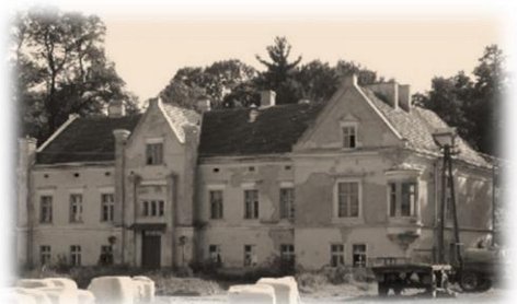
Fot. 79. Zabytkowy pałac w Szczaniecu (archiwum Lubuskiego Konserwatora Zabytków)
