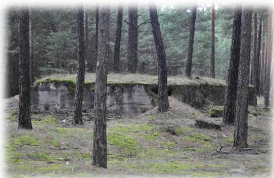
Fot. 110. Magazyny Depot — Leśnictwo Bolewiny, wydzielenie 102j (fot. B. Iwaniuk)
