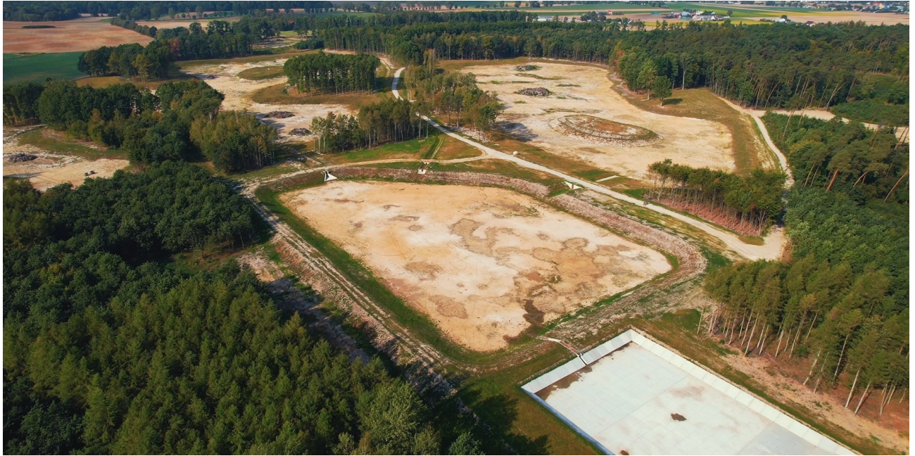
Fot. nr 16. Leśnictwo Szczepanowo- zakończone prace budowlane
