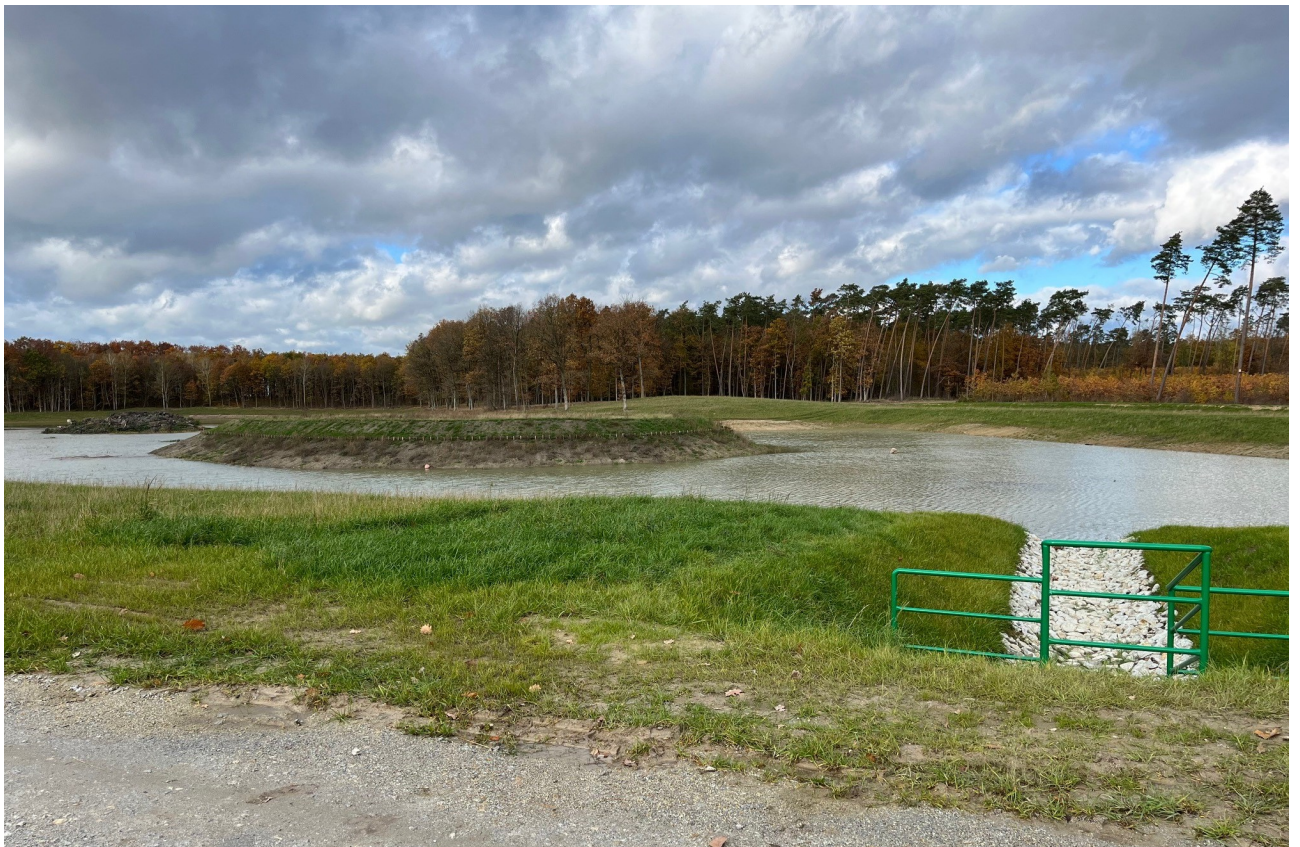
Fot. nr 17. Leśnictwo Szczepanowo- zbiorniki napelnione wodą
