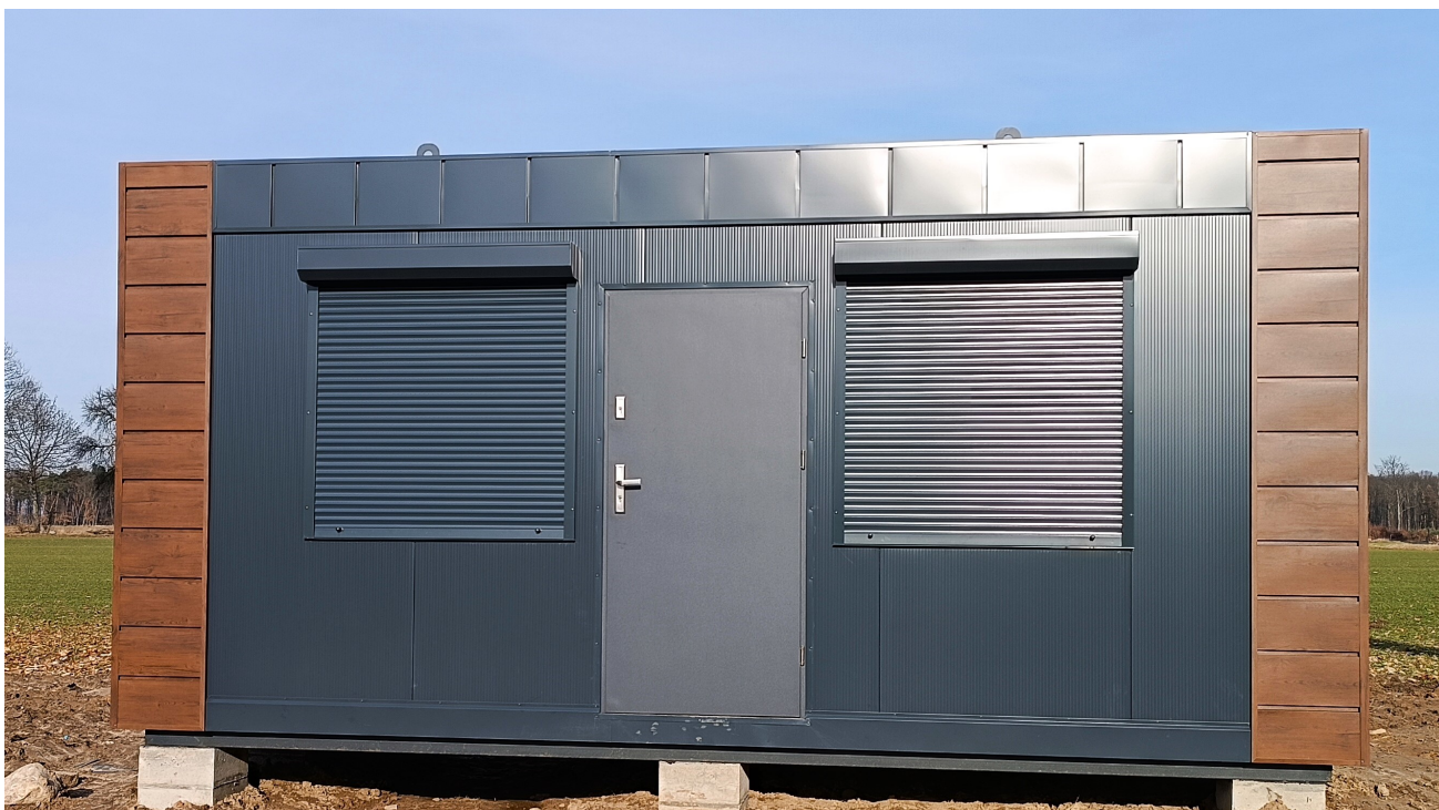
Fot. nr 1. Punkt Alarmowo-Dyspozycyjny w Nadleśnictwie Gołębki
