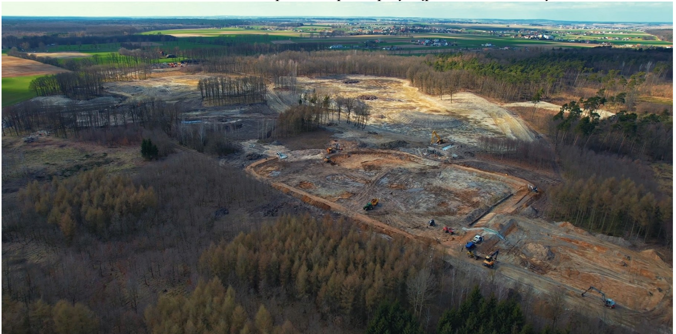
Fot. nr 15. Leśnictwo Szczepanowo- w trakcie prac budowy zbiorników
