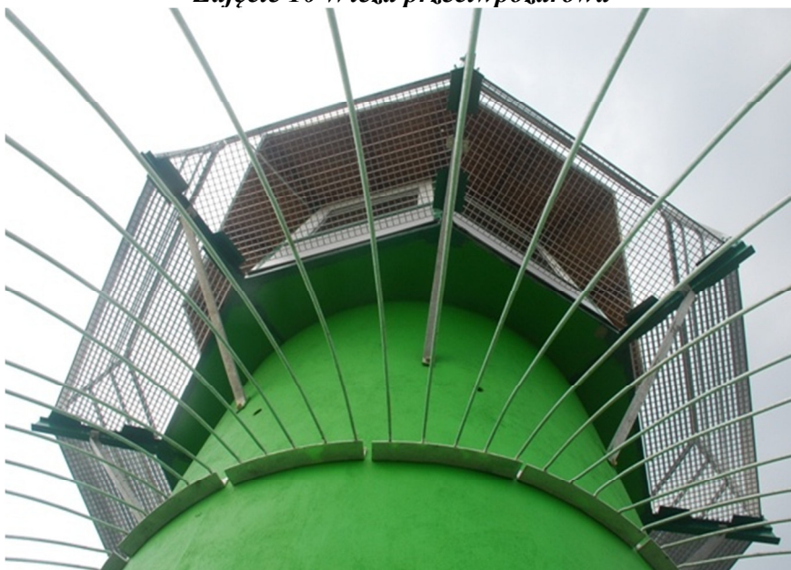
Zdjęcie 11 Wieża przeciwpożarowa
