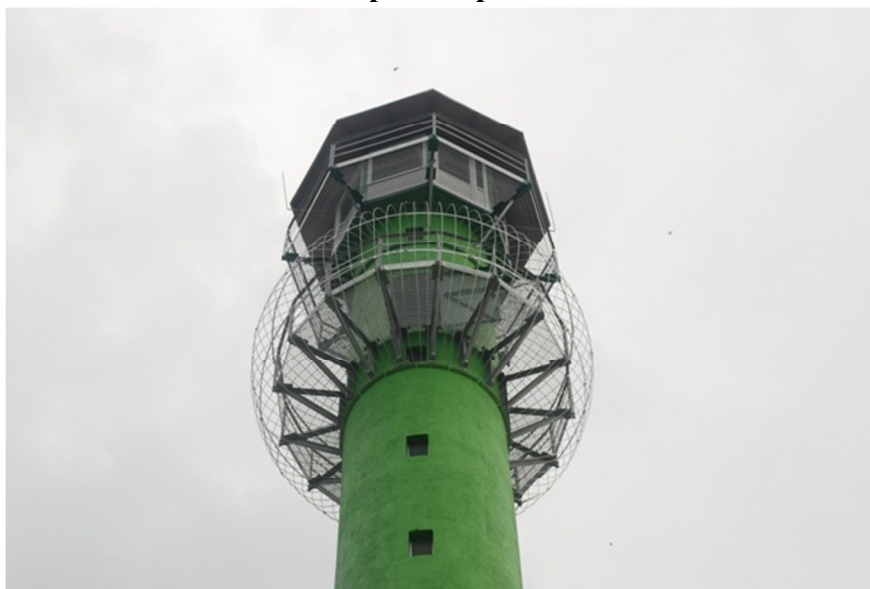
Zdjęcie 10 Wieża przeciwpożarowa
