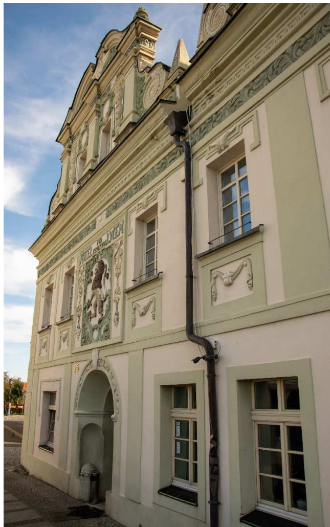
Fot. 23 Kamienica na rynku w Bytomiu Odrzańskim (fot. Dorota Baran)
