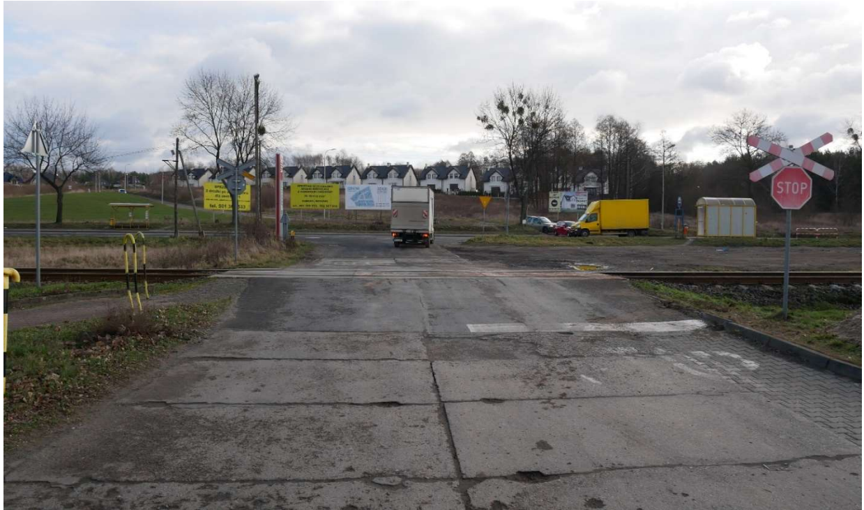
Zdjęcie 6 - Droga dojazdowa do przejazdu od strony lewej - źródło: dokumentacja PKBWK
