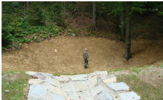
Miejsca na mikrozbiorniki wykopane na zboczach górskich zasilane spływem powierzchniowym przygotowane w Nadleśnictwie Piwniczna – Źródło: Archiwum CKPŚ.
