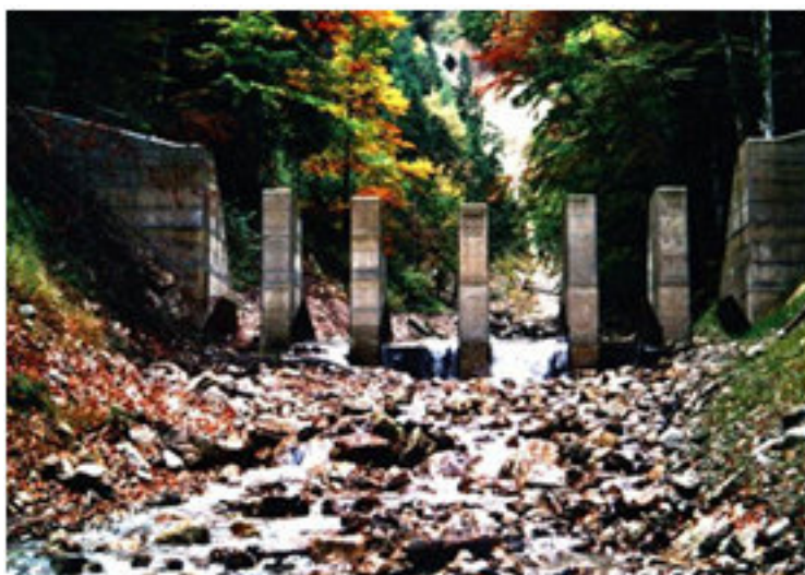
Zmodernizowana zapora szczelinowa (Austria)
