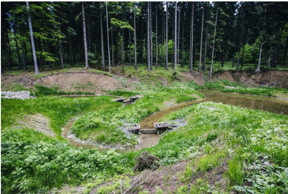
Zatoka zastoiiskowa i zastawki na cieku – Nadleśnictwo Międzyzlesie. Źródło: Archiwum CKPS.
