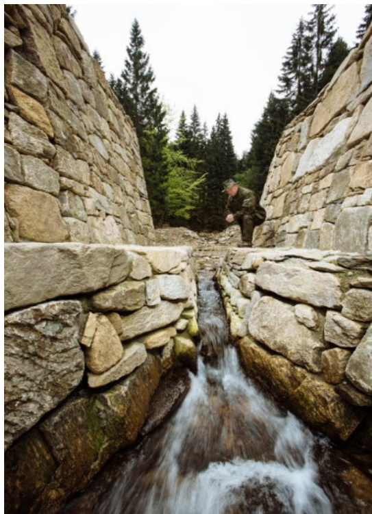
V-kształtny przelew wody ze zbiornika przeciwpowodziowego umożliwiający przejście rumowiska i samoczynne napełnianie i opróżnianie obiektu - Nadleśnictwo Międzylesie. Źródło: Archiwum CKPŚ. (rys. z prawej strony)
