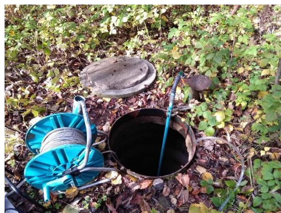
Fot. 2. Pobór wód podziemnych z piezometru
