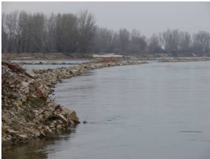
Fotografia nr 5.10. Tama równoległa współpracująca z tamami (ostrogami), tworząc tzw. „trawers”
