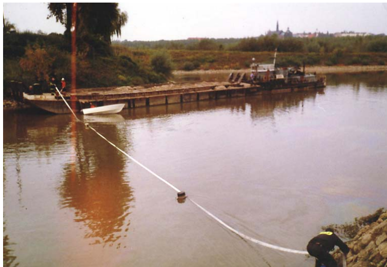
Fotografia nr 6.6. Sprawianie linii węzowej podwieszanej na pływakach, na jednostkę pływającą
