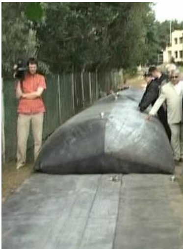
Fotografia nr 2.9. Zapory przeciwpowodziowe napelniane wodą
