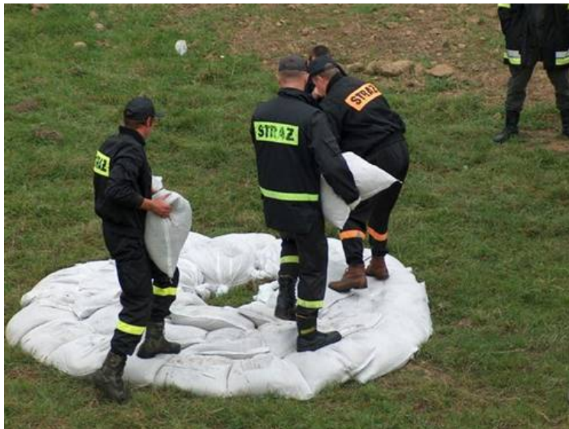
Fotografia nr 2.12. Wykonywanie uszczelnienia przebicia hydraulicznego
