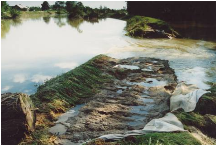
Fotografia nr 2.1. Wyrwa utworzona po przelaniu się wód powodziowych przez koronę wału
