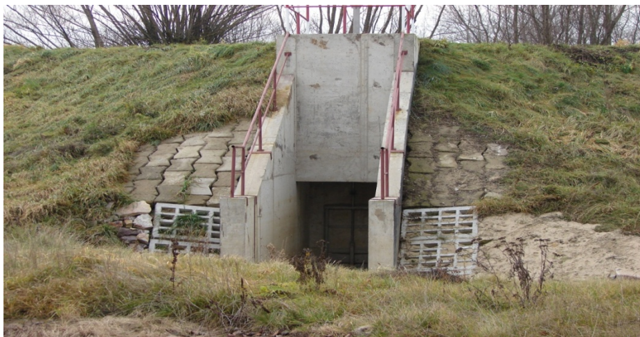
Fotografia nr 1.2. Śluza wałowa sterowana ręcznie
