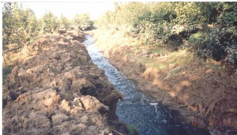
Fotografia nr 3.2. Likwidacja rozlewiska za pomocą spływu powierzchniowego
