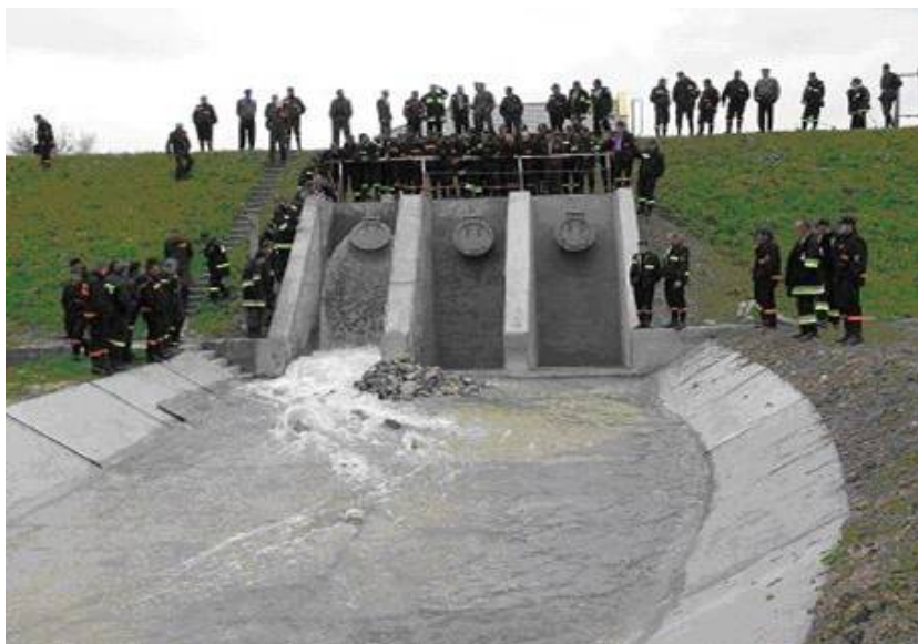
Fotografia nr 2.14. Wylot śluzy przepompowni przeciwpowodziowej
