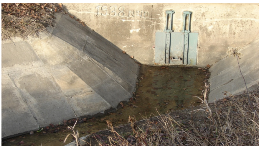
Fotografia nr 1.1. Śluza wałowa z ruchomą kłapą, działająca automatycznie
