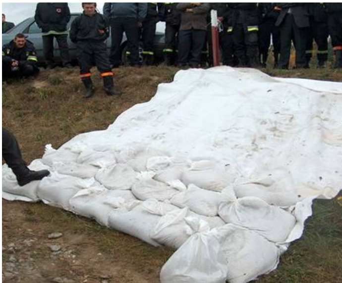
Fotografia nr 2.6. Wykonywanie uszczelnienia za pomocą geowłókniny i worków z piaskiem
