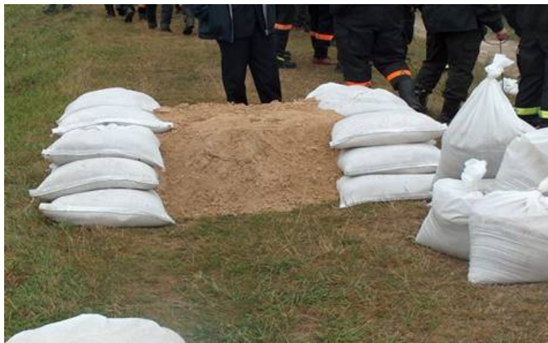
Fotografia nr 2.7. Podniesienie korony walu za pomocą worków z piaskiem i gruntu lub piasku
