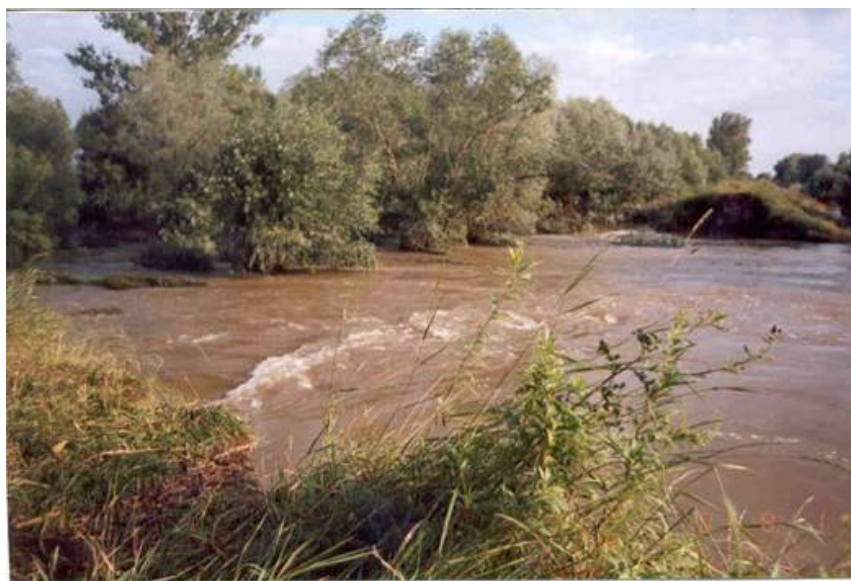
Fotografia nr 2.3. Wyrwa w wale przeciwpowodziowym powiększana przez wody powodziowe
