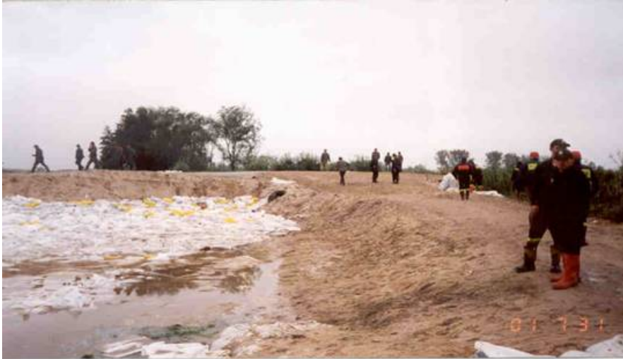
Fotografia nr 2.13. Dociążenie podstawy wału (z jednoczesnym uszczelnieniem przecieku)
