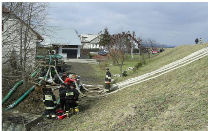
Fotografia nr 3.4. Przepompowywanie wody za wał
