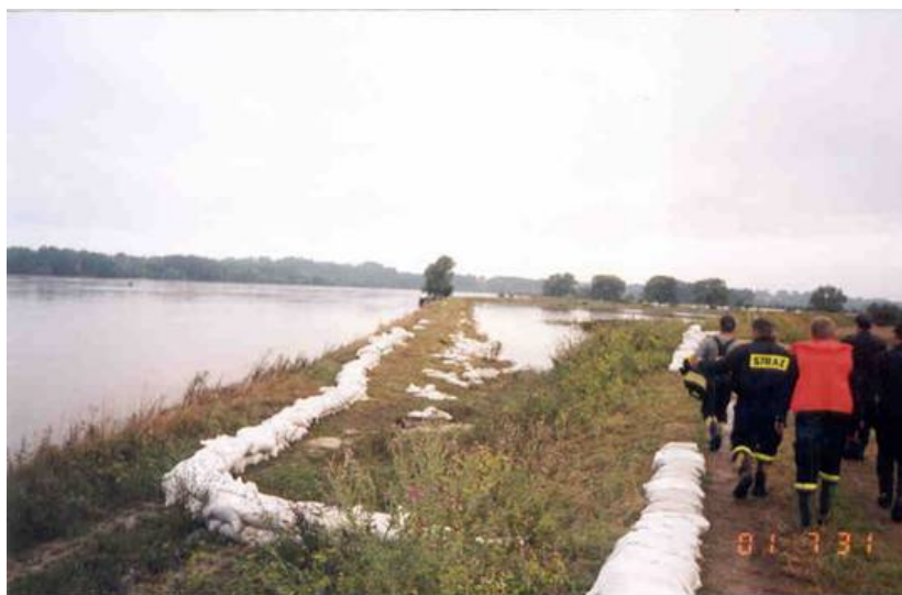
Fotografia nr 2.11. Podwyższanie wałów. Z lewej strony zniszczony wał „letni”
