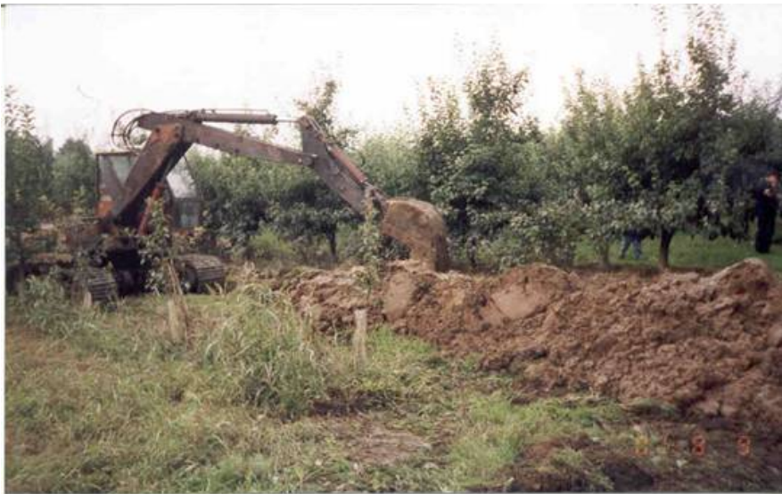
Fotografia nr 3.1. Wykonywanie rowów umożliwiających spływ wody z rozlewisk
