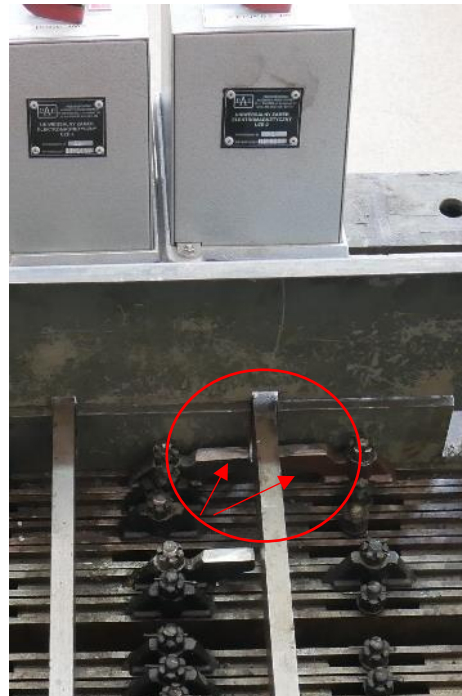
Zdjęcie 2 – Widok skrzyni zależności z zamkami elektromagnetycznymi UZE-02 na nastawni wykonawczej Gg2
