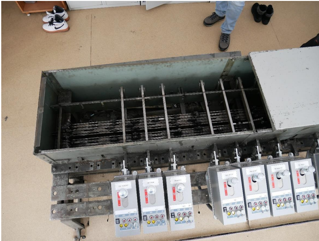
Zdjęcie 2 – Widok skrzyni zależności z zamkami elektromagnetycznymi UZE-02 na nastawni wykonawczej Gg2
