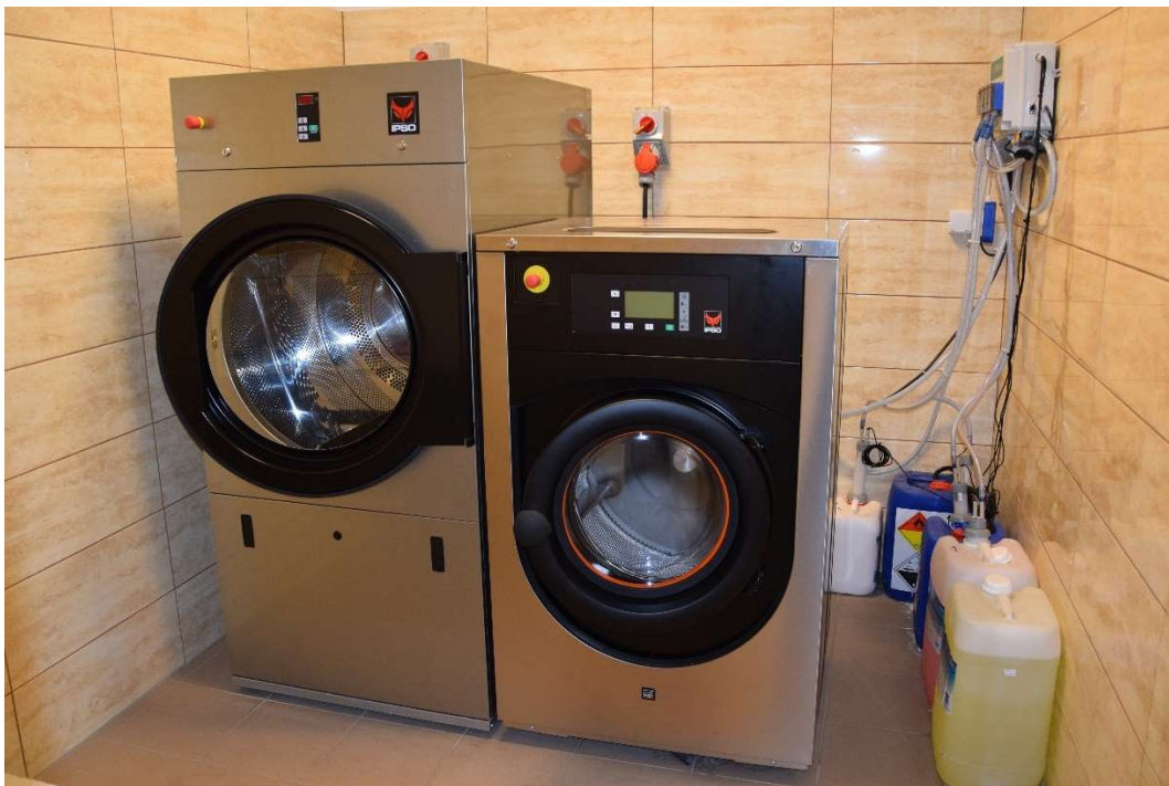
Fot. 5 Wyremontowane pomieszczenie pralni oraz zakupiona pralnica.
