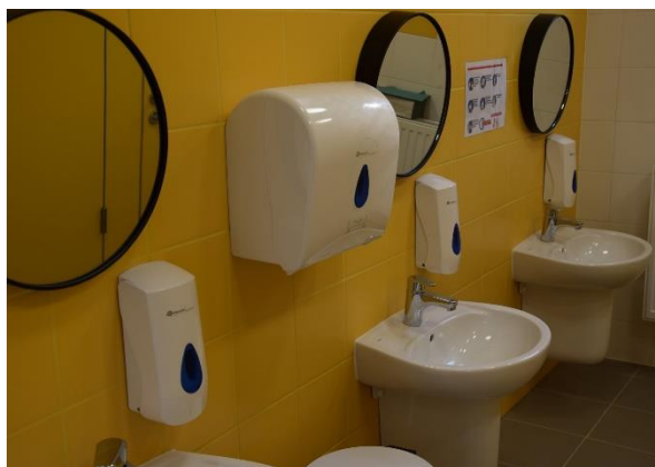
Rys. 4. Pomieszczenie sanitarne Przedszkola nr 3 w Wolsztynie
