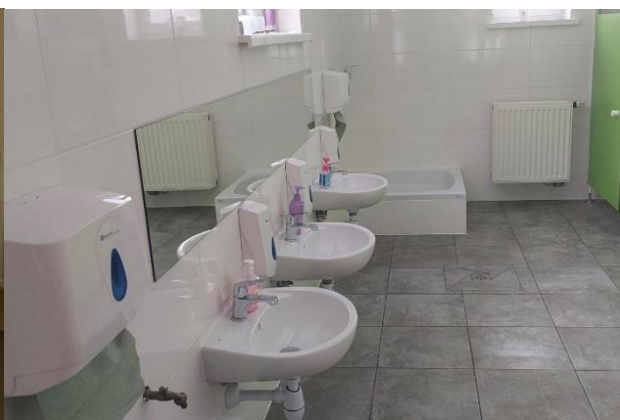
Rys. 5. Pomieszczenie sanitarne Przedszkola w Zespole Szkół w Opatowie
