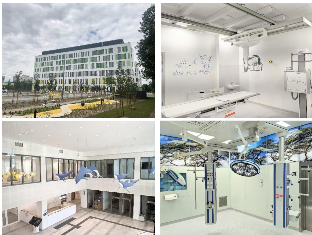
Rys. 3. Budynek Wielkopolskiego Centrum Zdrowia Dziecka w Poznaniu przy ul. A. Wrzoska 1
